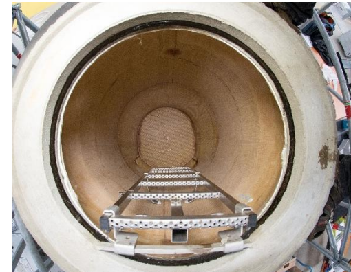
ausgekleideter Schacht
