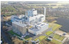
Das Heizkraftwerk Cottbus wurde modernisiert und im Jahre 2022 für eine klimafreundliche und sichere Fernwärmeversorgung wieder in Betrieb genommen. Dazu wurde der bisher kohlebefeuerte Teil der Anlage durch neue Gasmotoren ersetzt.
