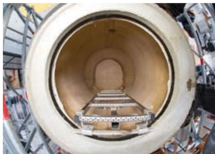
Die FlexRehaSchacht-Auskleidung schmiegt sich im Endergebnis perfekt an den Beton-Pumpschacht an
