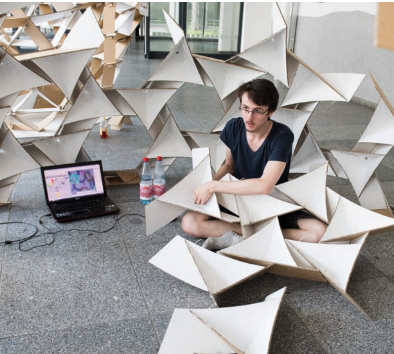
Der Student Alexander Melchior baut ein Tragwerk aus Wellpappe im Foyer des Großen Hörsaales auf
