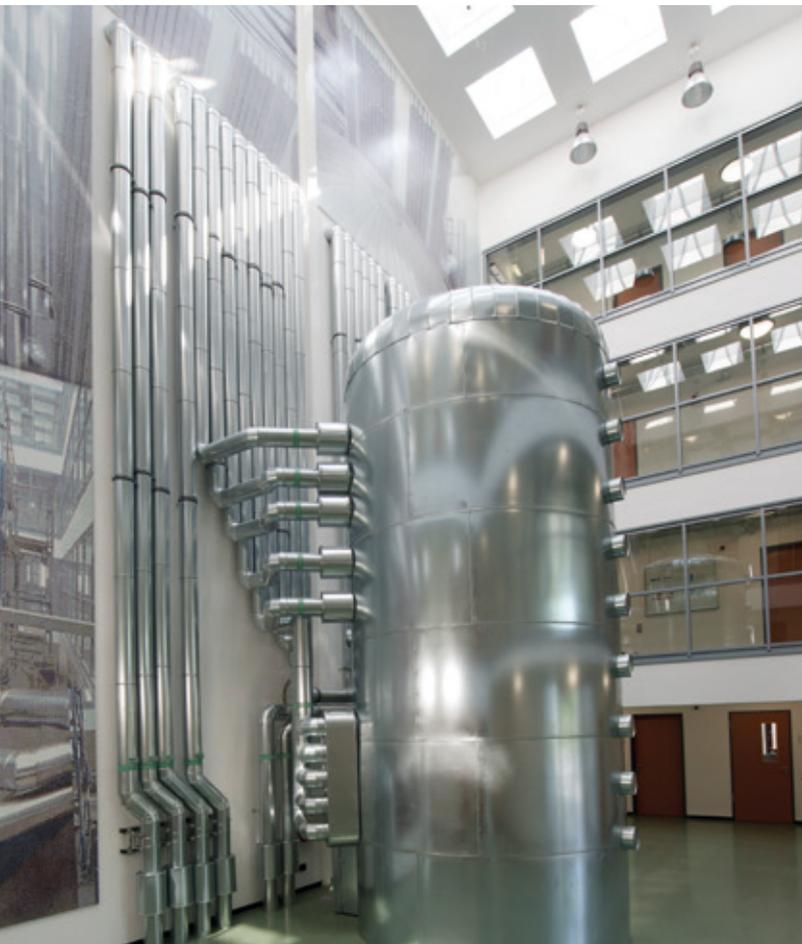
◀ Der Wärmespeicher im Foyer des neuen Zentrums für Energietechnologie dient dem Ausgleich von Wärmeangebot und -bedarf im Gebäude und gleichzeitig Forschungszwecken im Bereich der Speichertechnik
