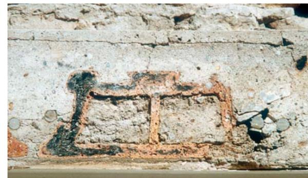
Schnitt durch eine Reformhohlsteinecke
