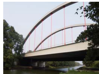
Bild der Brücke
