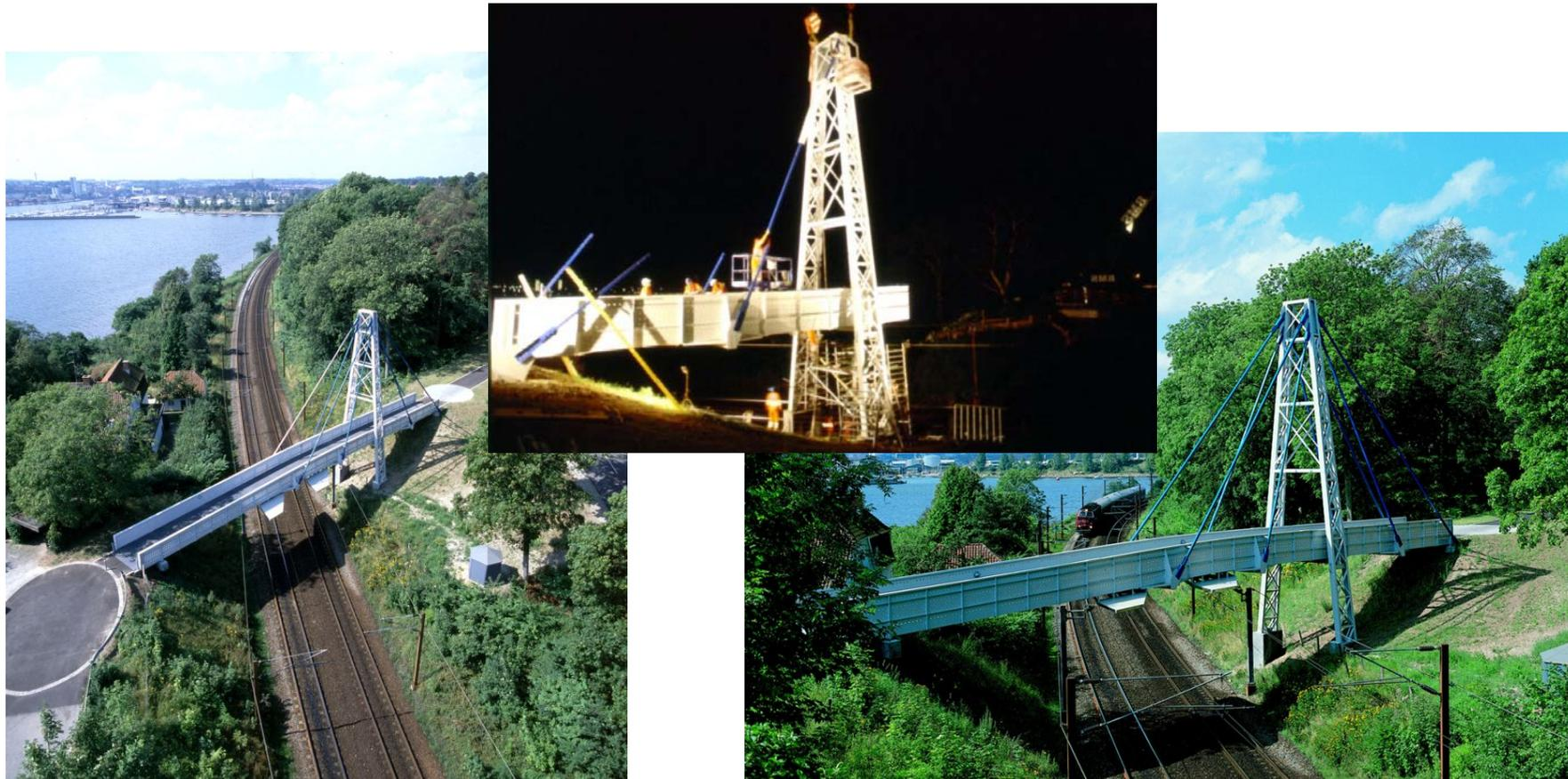
Charakteristische Daten: Länge: 40 m, Tragfähigkeit: 500 kg/m<sup>2</sup>, Fahrzeuge bis 5t,
