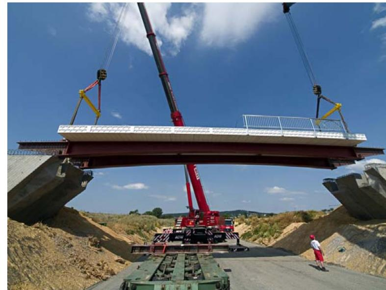
Charakteristische Daten: Länge: 22 m, Aufbau aus GFK-Profilen, Fertigstellung 2008
