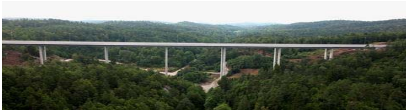
[Bild: Autobahnbrücke Bjellandsvad Bridge, Wolfgang Dornisch]
