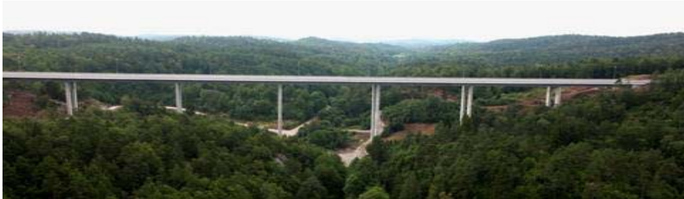
[Bild: Autobahnbrücke Bjellandsvad Bridge, Wolfgang Dornisch]
