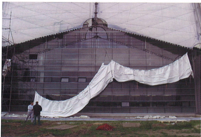
Bild 22. Fassadenanschluss Fig. 22. Closing membrane to glass façade
