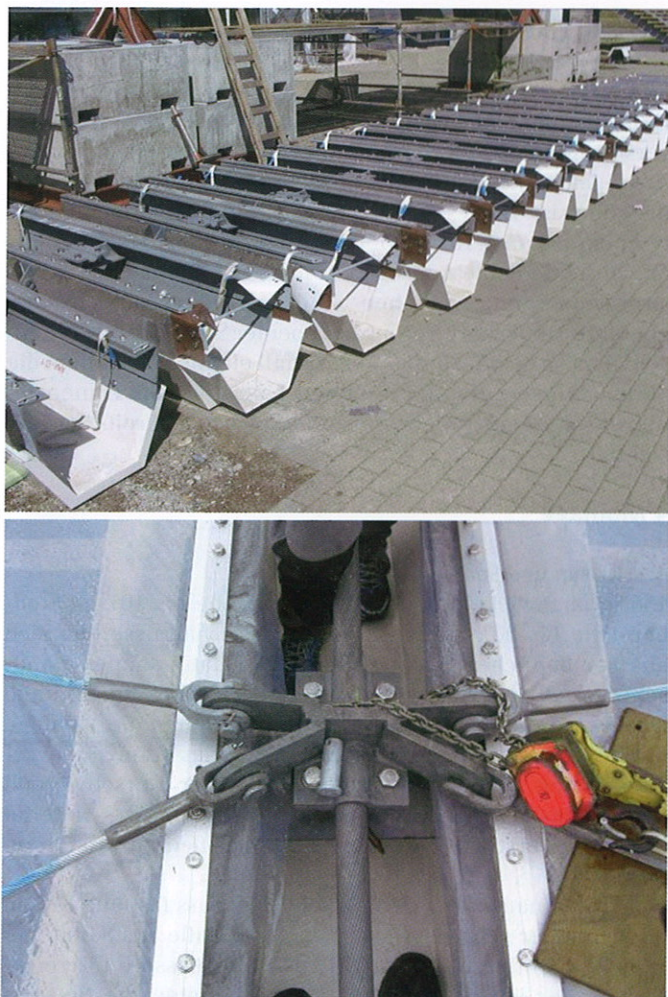
Bild 10. Vormontage und Montage der Rinnenteile Fig. 10. Preassembly and assembly of central gutter
