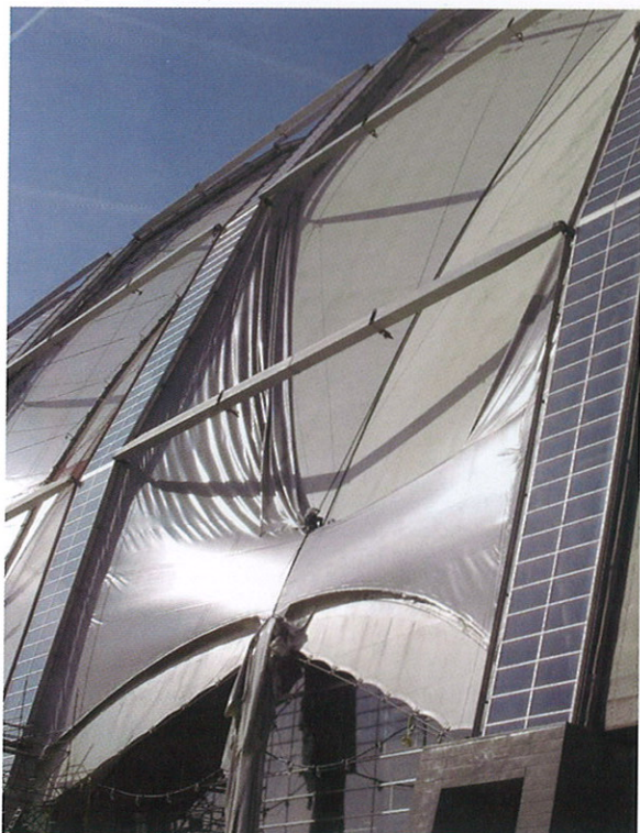
Bild 15. Demontage Außenmembrane Fig. 15. Dismantling of outer membrane
