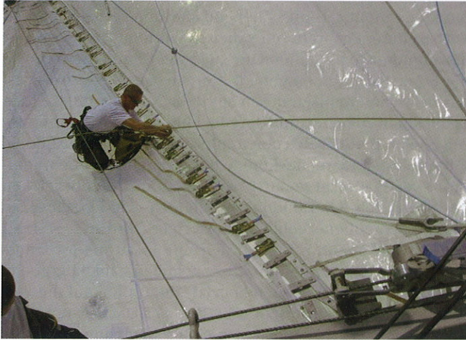
Bild 18. Verbindung zum nächsten Kissen Fig. 18. Connection line to next cushion
