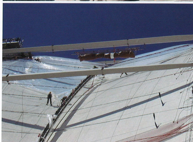
Bild 17. Kissenmontage Fig. 17. Erection of cushions
