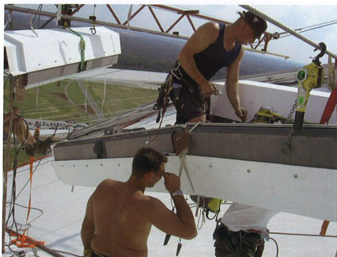
Bild 15. Demontage Außenmembrane Fig. 15. Dismantling of outer membrane
