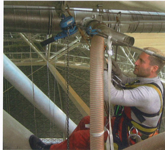
Bild 19. Montage der Luftversorgung Fig. 19. Assembling of air supporting system
