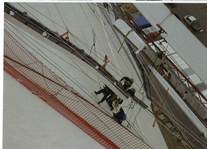
Bild 16. Montage Rinne Fig. 16. Assembly of gutterparts
