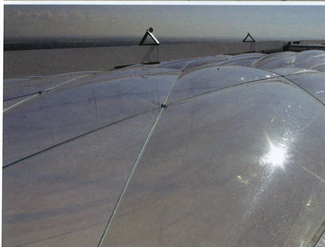
Bild 20. Montage oberes Seilnetz Fig. 20. Erection of upper rope net
