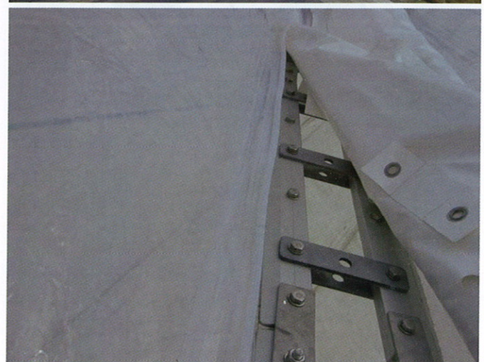
Bild 21. Dichtungen Fig.21. Closing flaps and sealing
