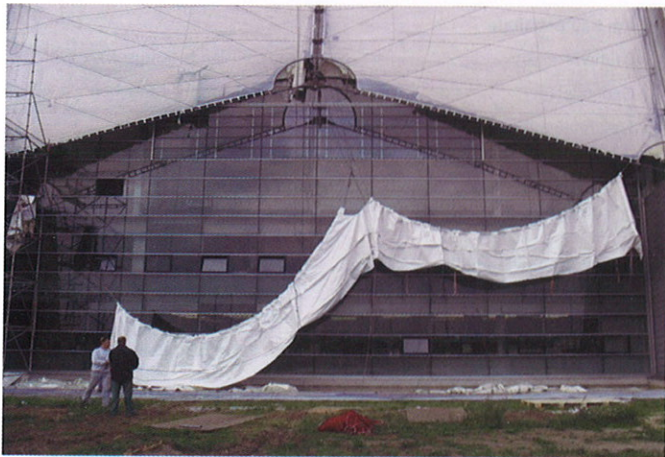
Bild 22. Fassadenanschluss Fig. 22. Closing membrane to glass façade
