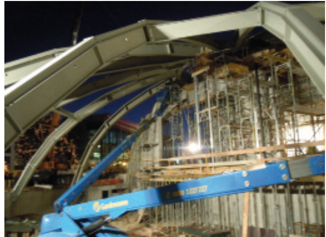
Bild 13. Polygonalschale, im Hintergrund Innenwand (Achse 1) Fig. 13. Polygon shell, in the background interior wall (axis 1)
