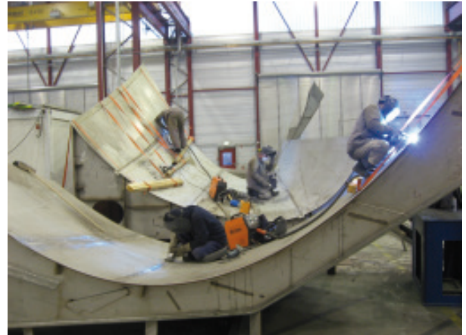
Bild 17. Verschweißen der Deckbleche Fig. 17. Welding of the cover plates
