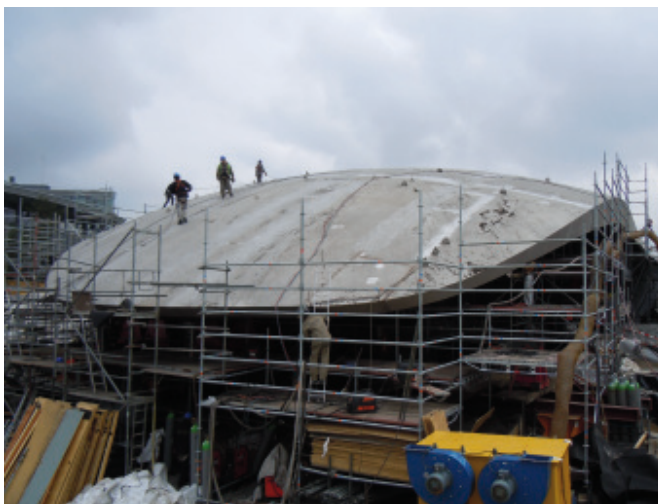
Bild 19. Montage der Segmente Fig. 19. Assembling of segments
