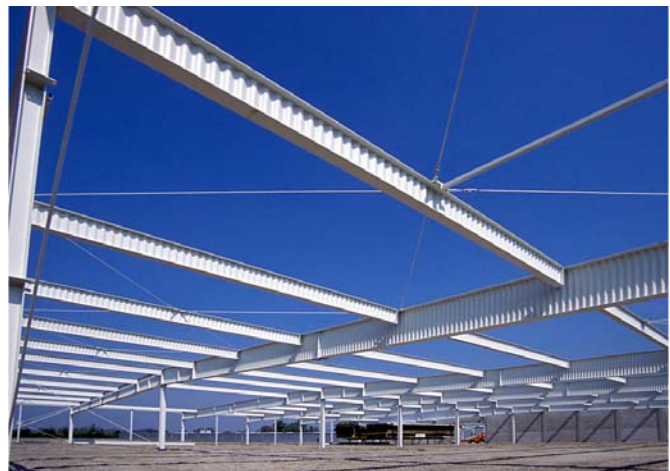
Bild 1. Stahlhalle mit Wellstegträgern
