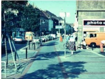
Abb.12: Rad-/Gehwegüberfahrt mit einer optisch (links) und fahrdynamisch (rechts) wirksamen Fahrbahnanhebung am Anschluss einer Tempo 30-Zone (Hannover)
