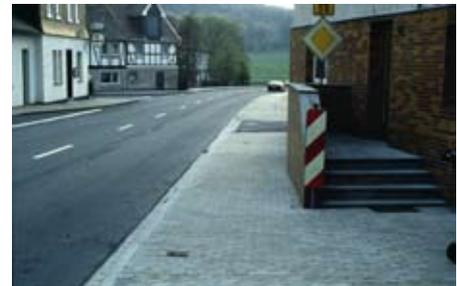
Abb.6: Nachher: Rückbau der Fahrbahn auf (5,50 m) Breite mit durchlaufendem Seitenraum
