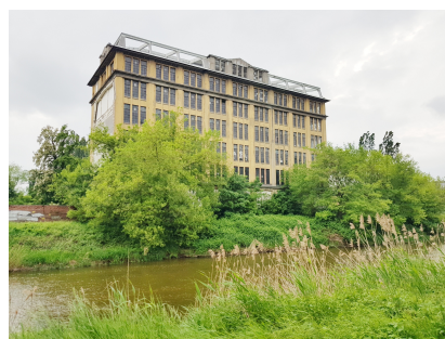
Guben: Leerstand Gebäude D „Gubener Wolle“
