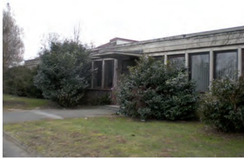
Foto: insar consult, Stefan Elsing Ehemaliges Bürogebäude
