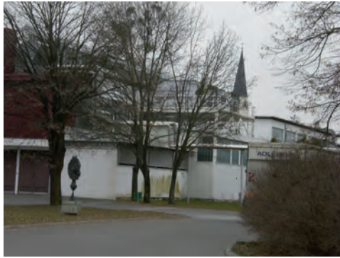
Foto: insar consult, Stefan Elsing Produktionsgebäude Mura in Murska-Sobota
