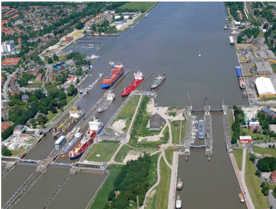
Luftbild Schleusen Brunsbüttel, Bildquelle: Wasserstraßen- und Schifffahrtsverwaltung des Bundes (WSV)
