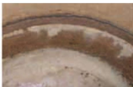
↗ Risse, undichte Schachtringverbindungen und Korrosion (v.l.n.r.) machen eine Sanierung der Pumpen unumgänglich (Foto: Lausitzer Klärtechnik GmbH)
