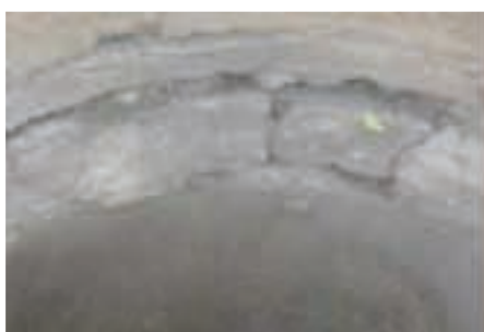
↗ Risse, undichte Schachtringverbindungen und Korrosion (v.l.n.r.) machen eine Sanierung der Pumpen unumgänglich (Foto: Lausitzer Klärtechnik GmbH)
