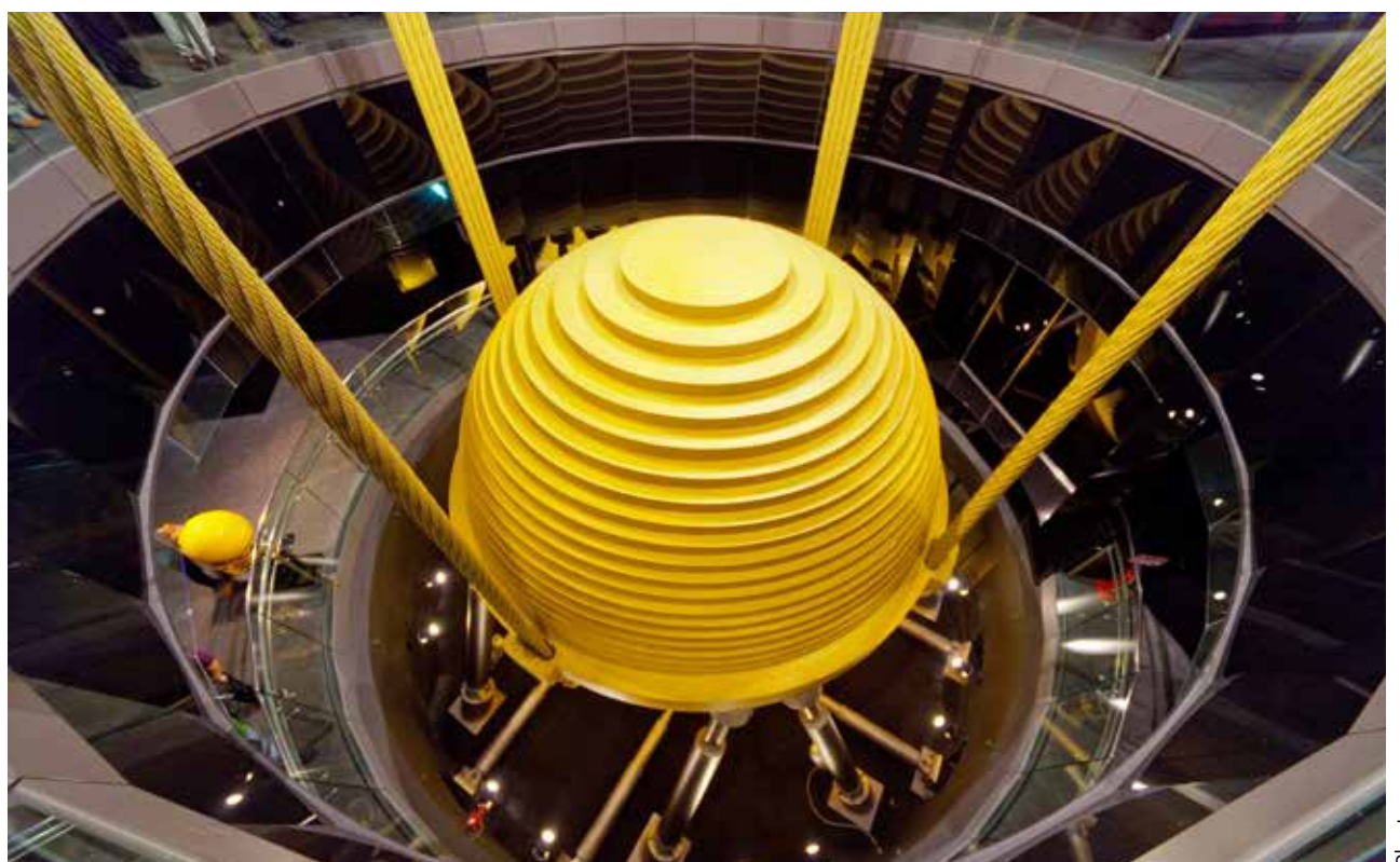
Mass damper Taipei 101 / Schwingungsdämpfer Taipei 101
