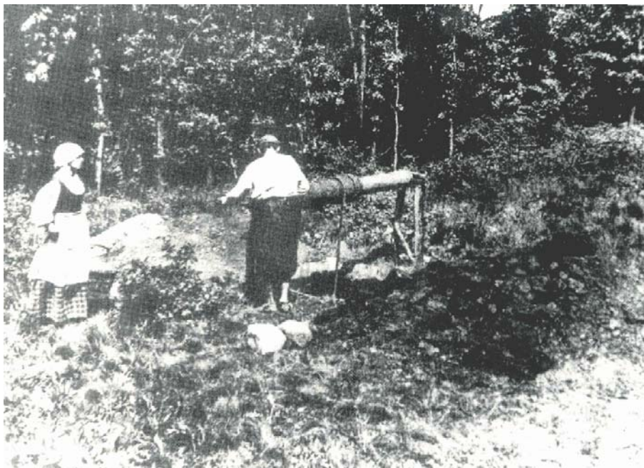
Abb. 1: Braunkohlenförderung in einem Kleinstbergwerk im Kuhlenbau (LAUBAG 2000) 6
