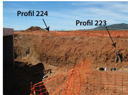
Abbildung 226: Baugrube mit Profil 223 und Profil 224
