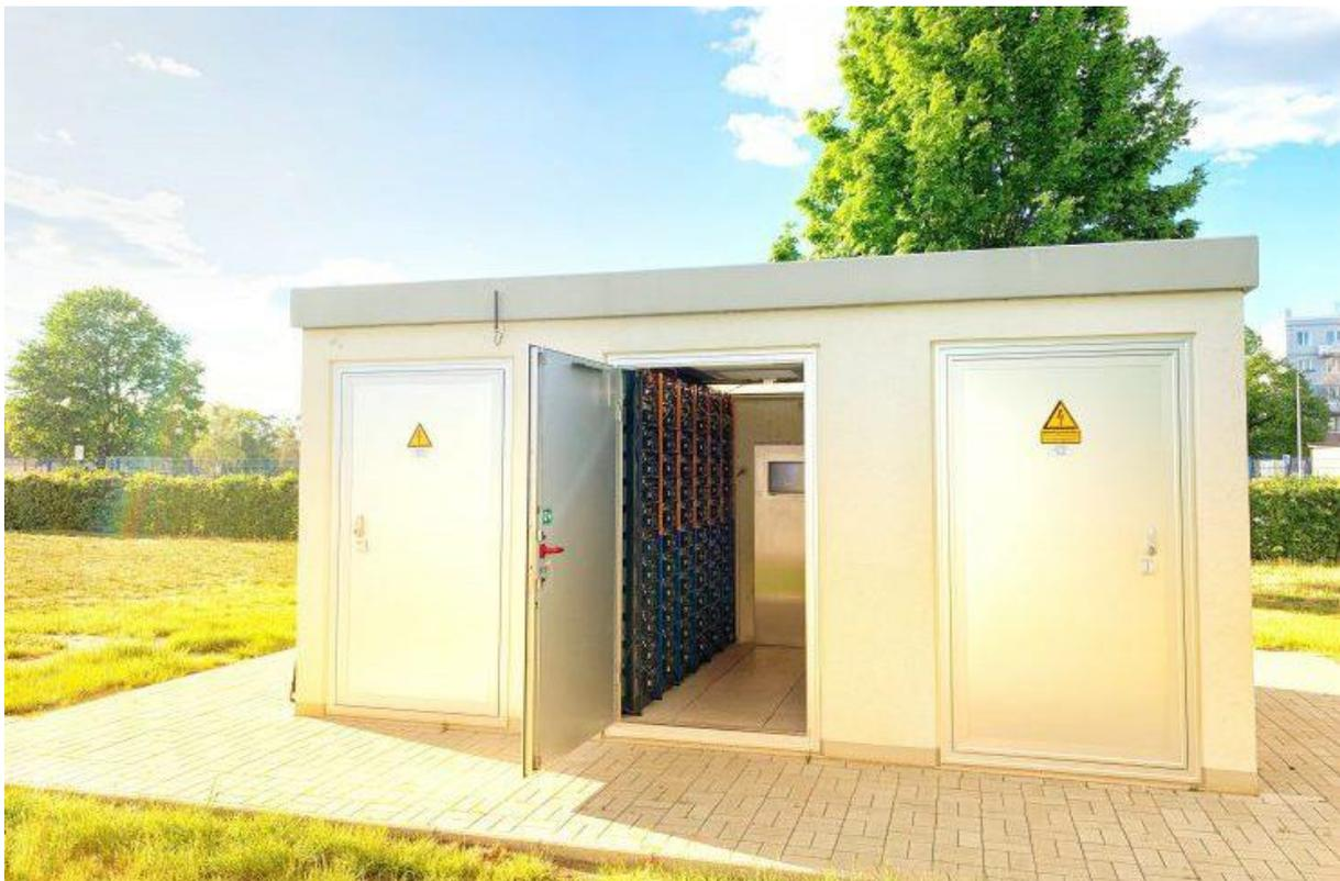
Bild 11: Beispiel für die mögliche Ausführung des zentralen Batteriespeichers auf dem Zentralcampus als Kompaktstation ähnlich handelsüblicher Mittelspannungs-Transformatorstationen
