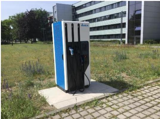
a) Schnell-Ladesäule auf dem BTU-Zentralcampus stirnseitig vom Hauptgebäude mit 4 Ladepunkten und DC-Ladeleistung 100 kW, AC-Ladeleistung 43 kW
