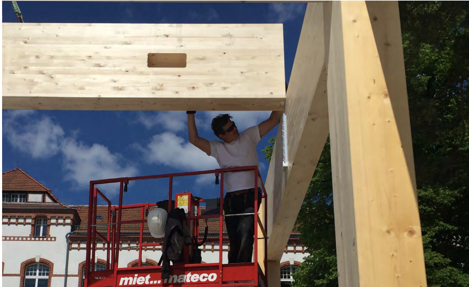
Reversibler nicht sichtbarer Spezialverbinder: Stütze - Unterzug
