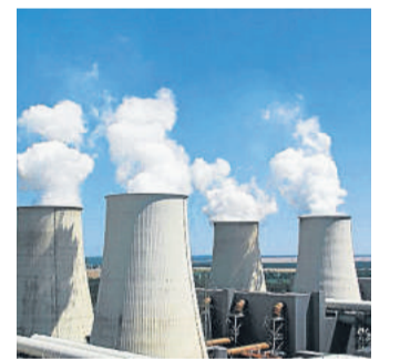
BLZ/BLANKENAGEL Kohlekraftwerk Jänschwalde
