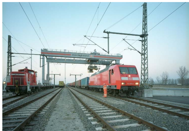
Abb. 7 Ein KLV-Zug wird im Ladegleis mit der Streckenlokomotive bespannt und verlässt ohne Rangieraufwand das Terminal Großbeeren (Bild Pressedienst DBAG)
