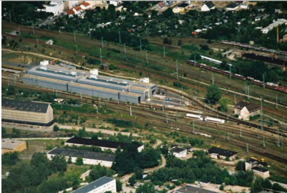
Abb. 11 Luftbild des modernen Instandhaltungswerkes Cottbus der DB Regio AG mit den beiden zugängen Hallen für die Fahrzeugbehandlung und -reinigung (Bild: Harald Großstück)
