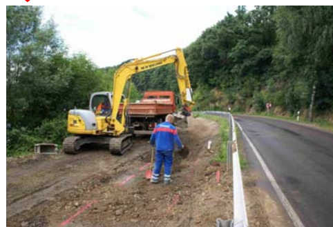
↓ Nicht selten wurde bei starkem Regen der Bahnkörper entlang der Talsperre vom Ackerboden der angrenzenden Felder überspült. Jetzt fangen Hanggräben und Kaskaden das Regenwasser auf und leiten es in den Stausee.
