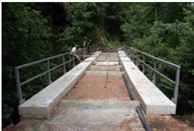
↓ sanierte Gewölbebrücke mit Zugkraftsicherung zwischen den Randkappen
