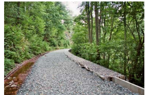
↓ Die gleiche Stelle drei Monate später (Sept. 2008), hier in Blickrichtung Freital-Hainsberg: Auf den Felsankern gegründet verhindern Gabione das spätere Abrutschen des Gleises.
