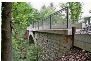
↓ Details der sanierten Goldgrubenwegbrücke: Drahtgittergeländer, Ankerkappen und Schotterhalterung
