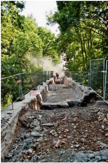
↑ unmittelbar am Bahnhof Seifersdorf: Hochdruckreinigungsarbeiten an der ausgekofferten Gewölbebrücke
