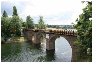
↑ Gerüstschalung für die neue Fahrbahnwanne der Bormannsgrundbrücke
