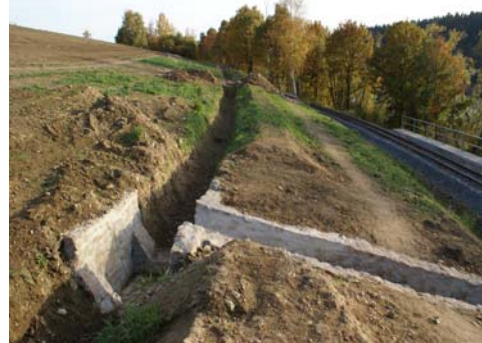
↓ Nicht selten wurde bei starkem Regen der Bahnkörper entlang der Talsperre vom Ackerboden der angrenzenden Felder überspült. Jetzt fangen Hanggräben und Kaskaden das Regenwasser auf und leiten es in den Stausee.
