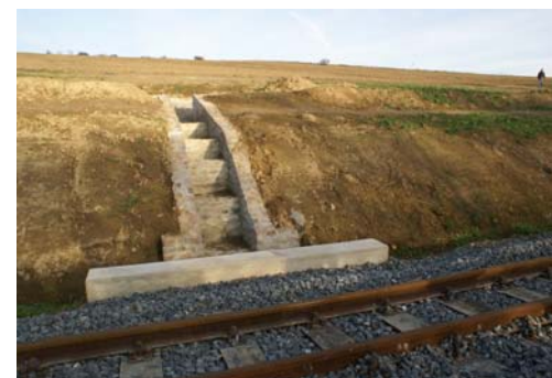
↓ Nicht selten wurde bei starkem Regen der Bahnkörper entlang der Talsperre vom Ackerboden der angrenzenden Felder überspült. Jetzt fangen Hanggräben und Kaskaden das Regenwasser auf und leiten es in den Stausee.
