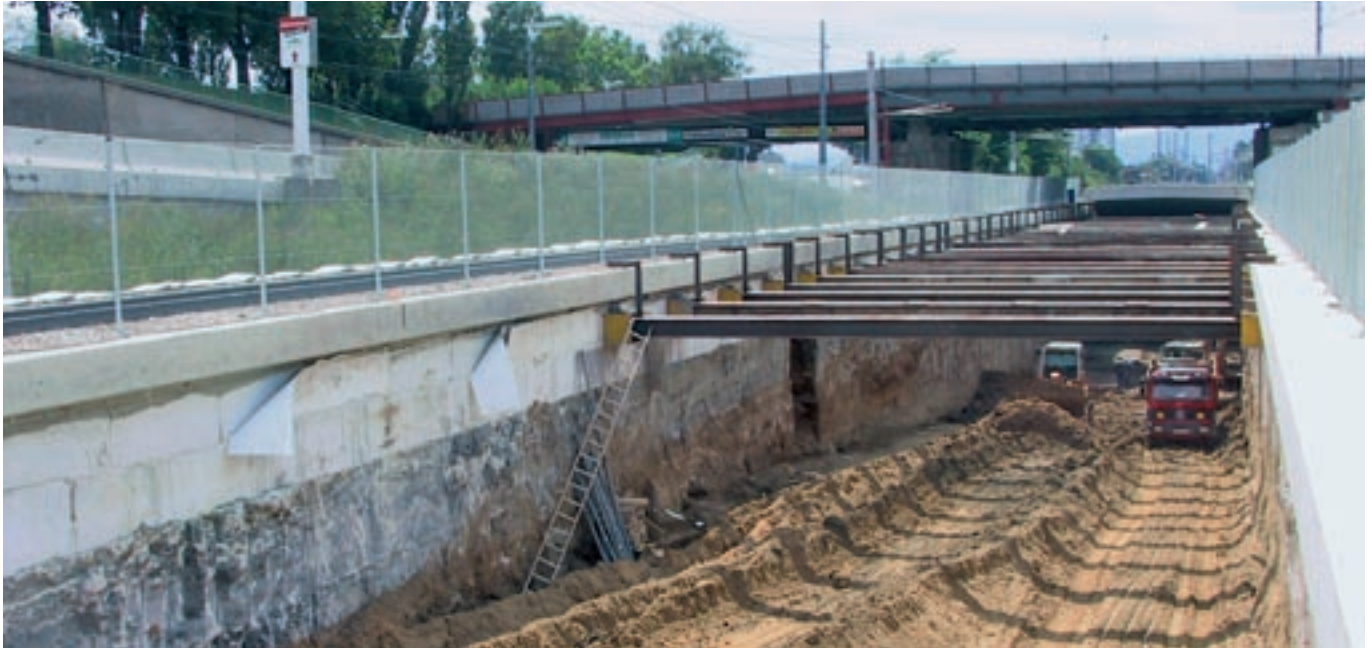
Aushub im Bereich des Südportals des Lainzer Tunnels
