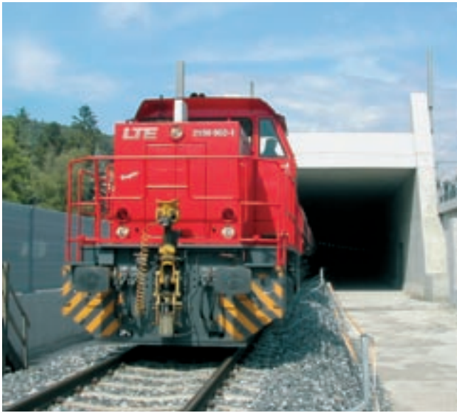
Rampenbauwerk Portal Purkerdorf
