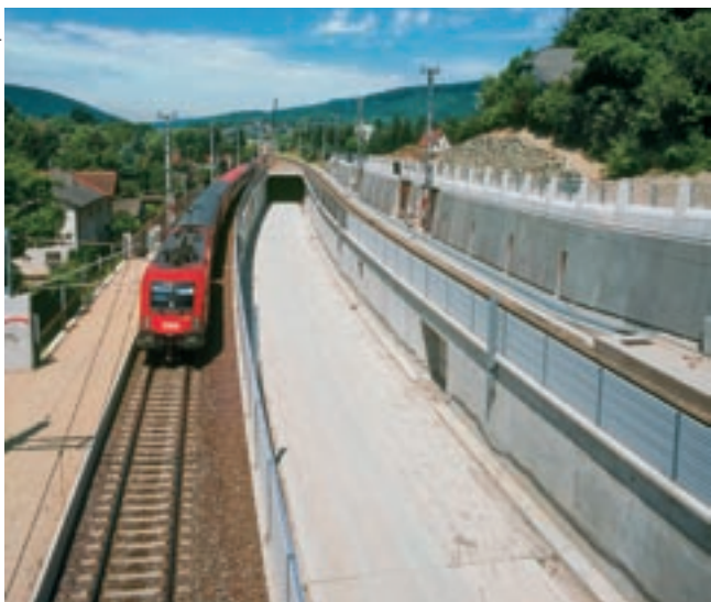
Rampenbauwerk Wolf in der Au mit Portal
