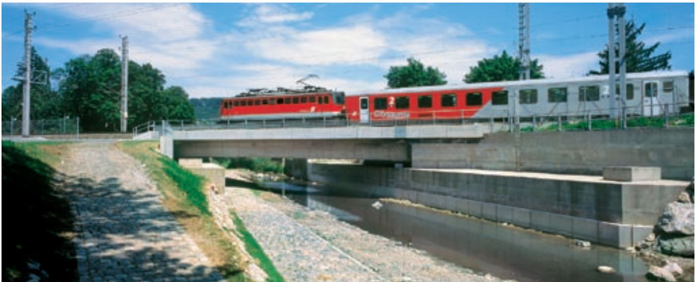
Brücken der Westbahn über den Mauerbach
