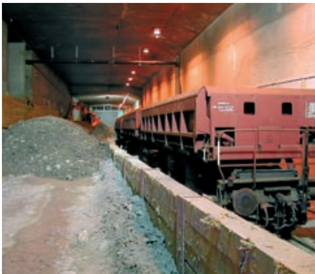
Ladegleis der Weichenhalle
