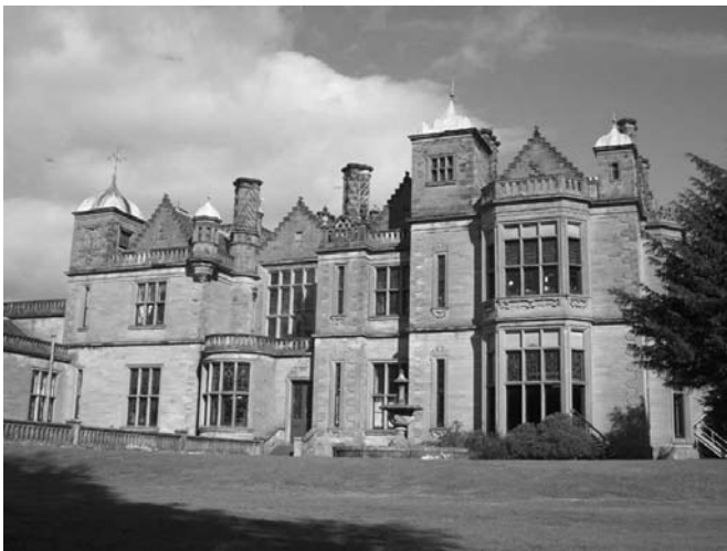
1 House of Falkland von Westen (Aufnahme: Alexandra Lotz)
