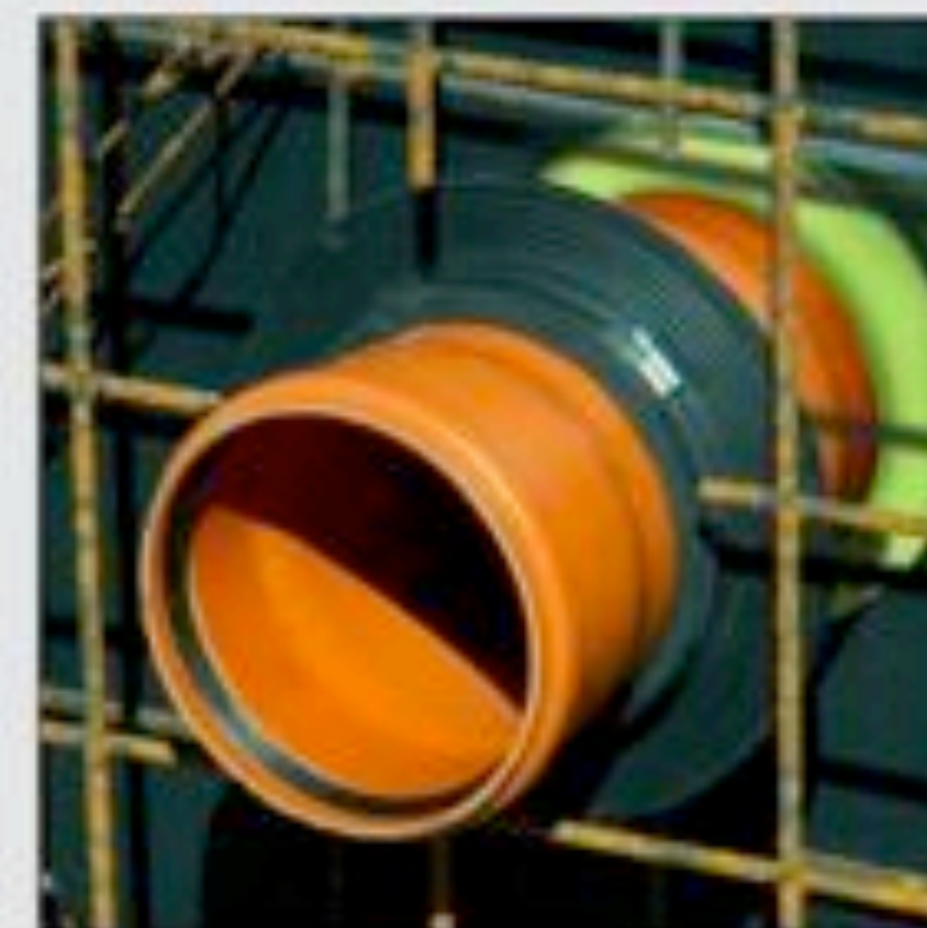
Elmco® - RD Rohrdurchführung in der Wand vor dem Betonieren
