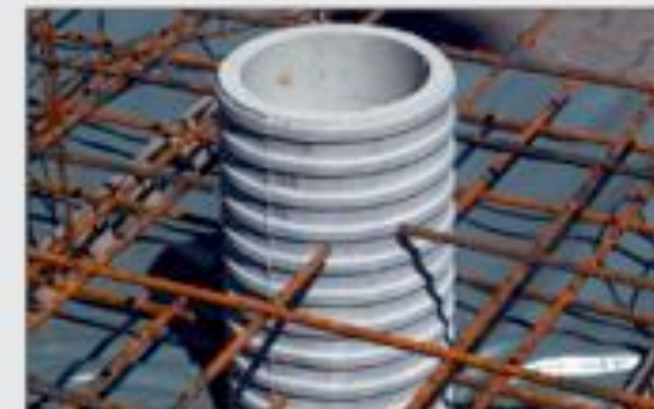
Elmco® - FR Futterrohr als Durchführung in der Sohlplatte
