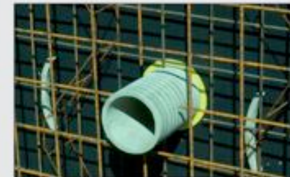
Elmco® - FR Futterrohr als Wanddurchführung, gelben Deckel für die Befestigung an der Schalung bitte separat bestellen.
