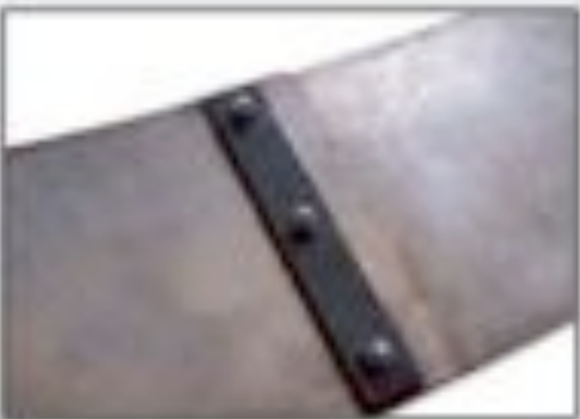
Stoßverbindung Fugenblech mit FBRV
