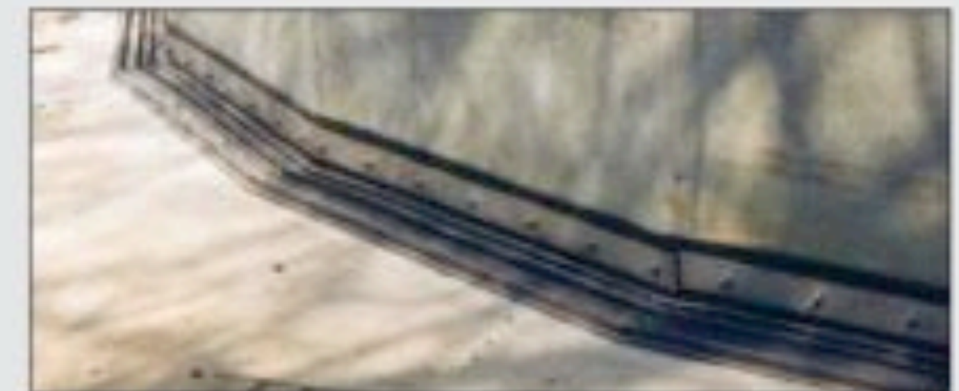
Außenliegendes Dehnungsfugenband als Klemmkonstruktionen → Seite 25
