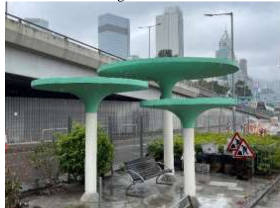
Abb. 1: Beton-Pavillons in Causeway Bay vor der Renovierung
