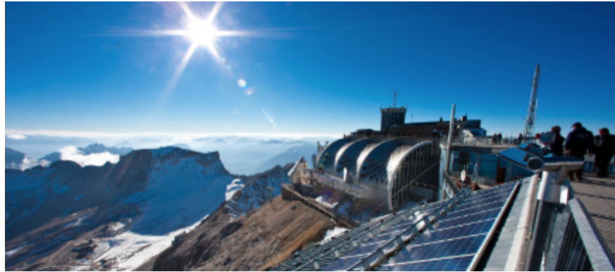
Bild: wikipedia.org / Fotovoltaik am höchsten Punkt Deutschlands
