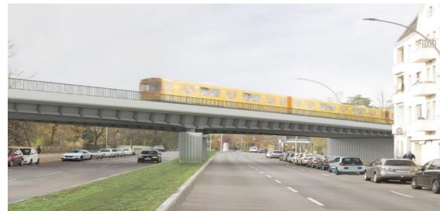
Streckensanierung U6 Nord
