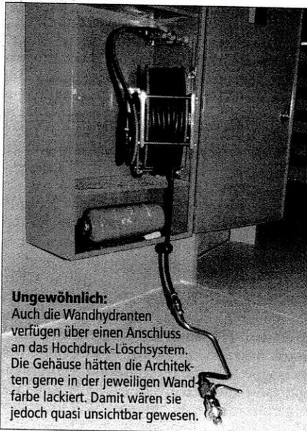
**Ungewöhnlich:** Auch die Wandhydranten verfügen über einen Anschluss an das Hochdruck-Löschsystem. Die Gehäuse hätten die Architekten gerne in der jeweiligen Wandfarbe lackiert. Damit wären sie jedoch quasi unsichtbar gewesen.
