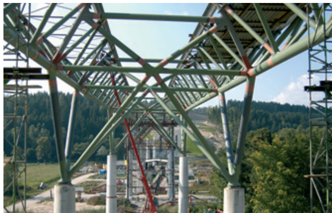
Talbrücke St. Kilian
