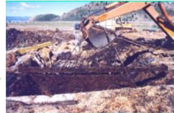
Bau einer Reaktiven Wand
