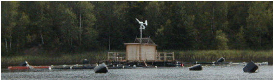
Bild 5-1 30 m-Enclosure mit Reaktoren im Tagebausee 111
