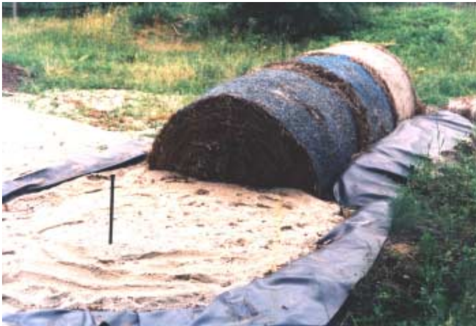
Abbildung 3.21 Denitrifikationsreaktor bestehend aus Strohballen und nachgeschaltetem Kiesfilter
