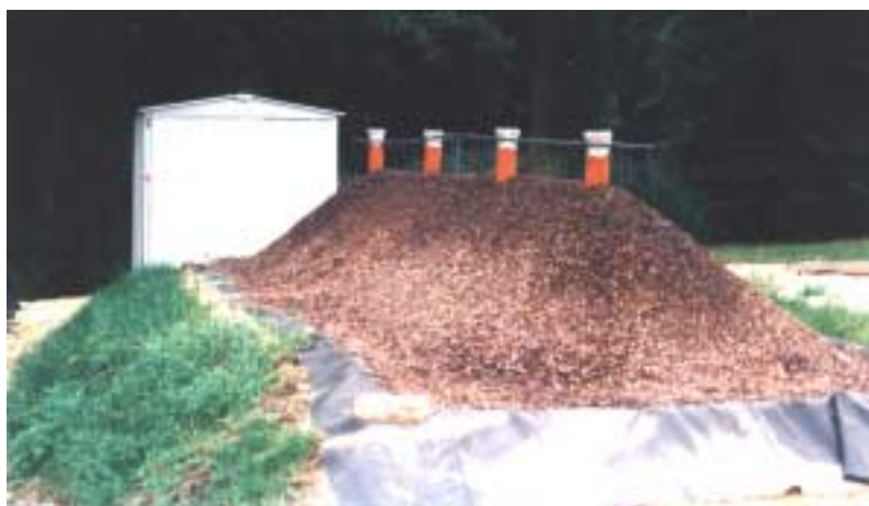
Abbildung 3.4 Lavaschüttung als Rieselfilter zur Restnitrifikation
