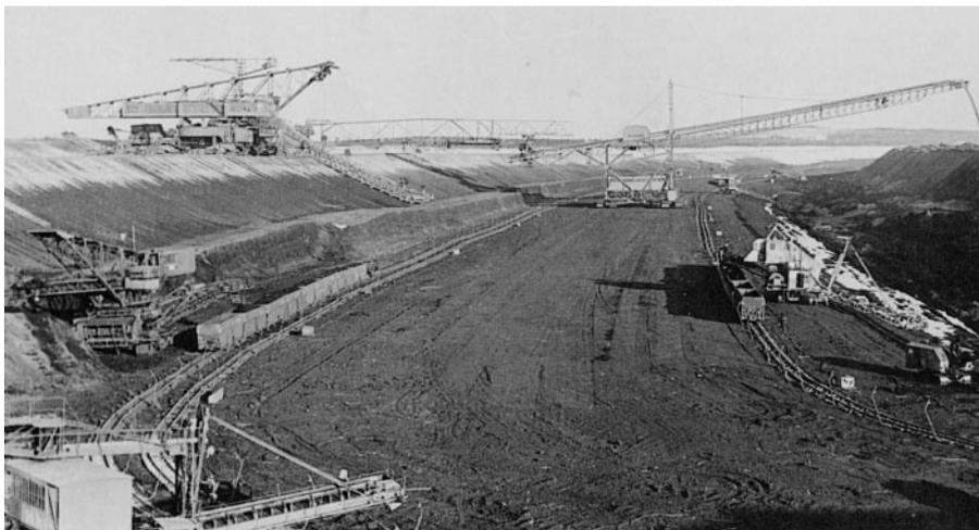
**Abb. 2.3** Förderbrücke im Tagebau Niemtsch. Am linken Bildrand im Hintergrund ein im Tiefschnitt arbeitender Eimerkettenbagger.
