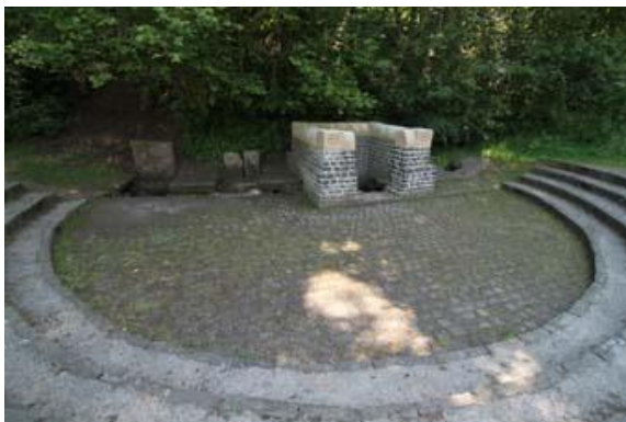
Abbildung 80: Brunnenstube „Grüner Pütz“ bei Nettersheim in der Eifel
