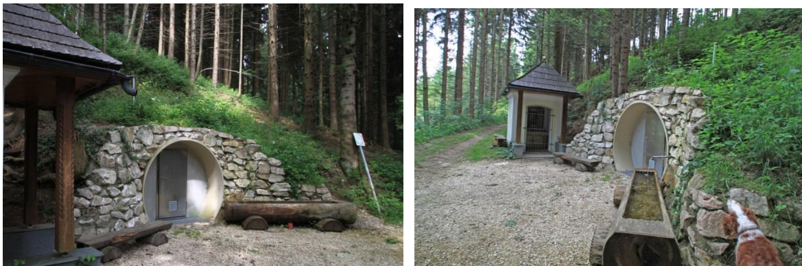
Abbildung 119: Auleitenbründl und moderne Quellfassung in Frankenmarkt, Oberösterreich
