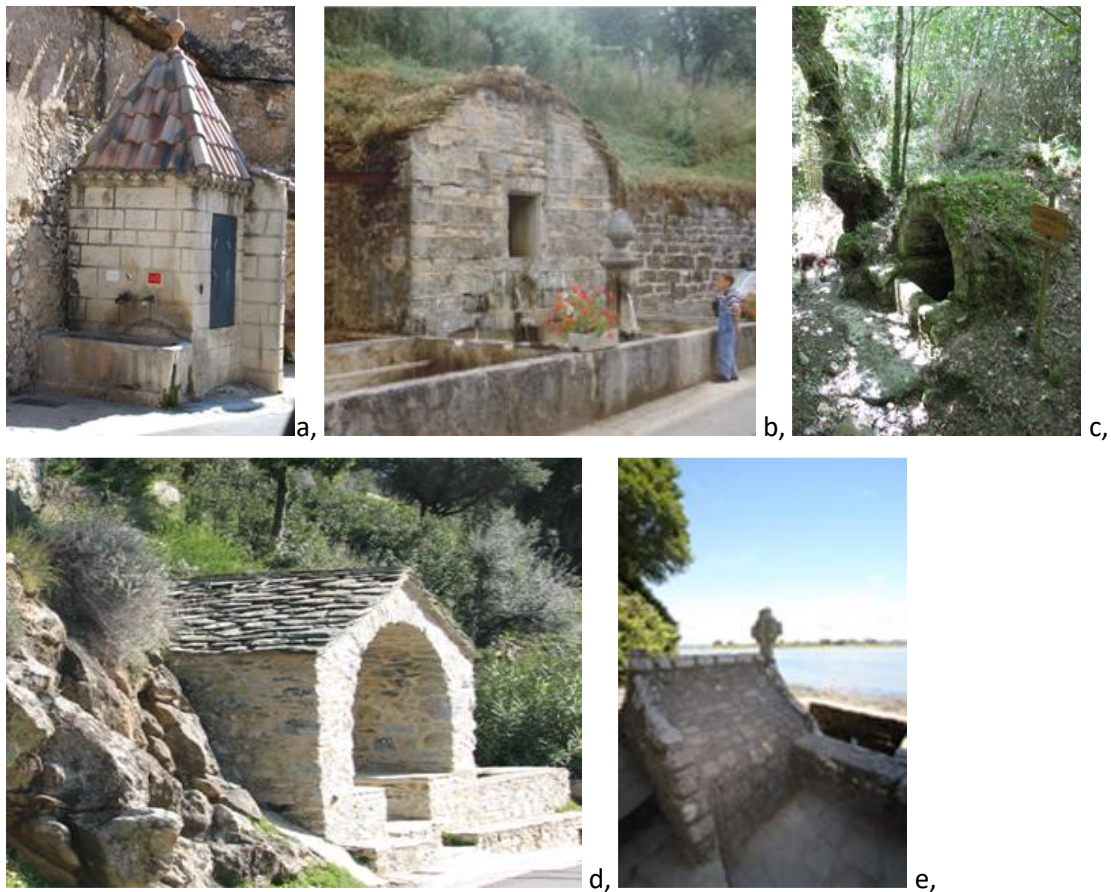
Abbildung 36: Beispiele gemauerter Quellhäuser in Frankreich a) Arbonas, Lanquedoc Roussillon, b) St. Lothain, Franche-Comté, c) Fontaine du Coumels, Romengoux, Ariege, d) Ogliastru, Korsika, e) St. Cado, Bretagne
