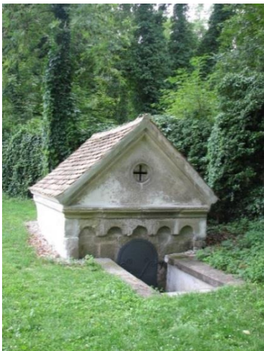
Abbildung 90: Brunnenstube im Kloster St. Georg, Regensburg -Prüfening
