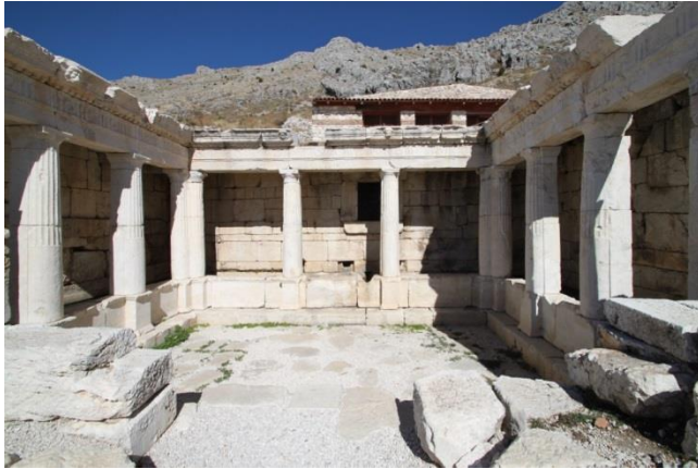
Abbildung 60: Dorisches Brunnenhaus in Sagalassos,
