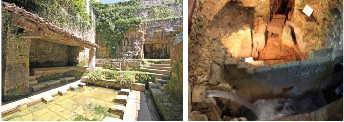
Abbildung 84: Fontaine romaine du Moulin in Venerand, Frankreich, Auf dem linken Foto ist im Hintergrund die Quellfassung und im Vordergrund das Waschhaus, auf dem rechten der Einlauf zur Mühle und im Hintergrund der Beginn des antiken Aquädukts zu sehen.
