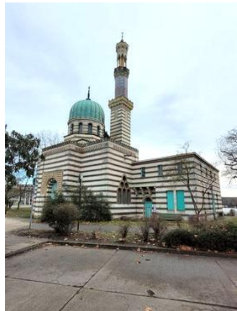
Abb. 6.30: Pumpwerk (Moschee) an der Neustädter Havelbucht
