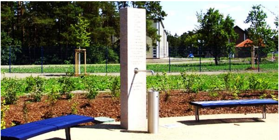
Abb. 8.17: Trinkbrunnen am Wasserwerk Tettau
