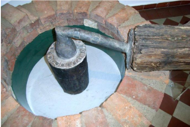
Abb. 7.50: Ziegelsteinbrunnen in der Almstadtstraße 16 in Berlin-Mitte
