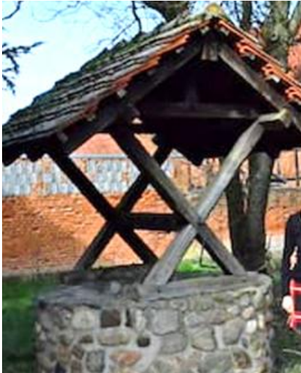
Abb. 5.6: Schachtbrunnen auf dem Gelände des Stifts Marienfließ
