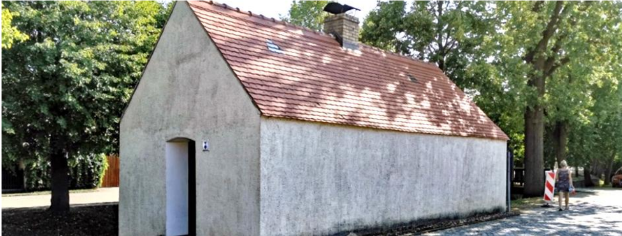
Abb. 8.5: Technisches Denkmal des ehemaligen Brunnenhauses und späteren Pumpstation in Großthiemig
