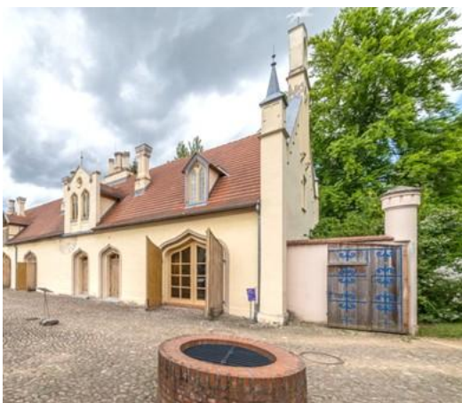
Abb. 6.70: Marstall des Branitzer Schlosses, im Vordergrund der Versorgungsbrunnen
