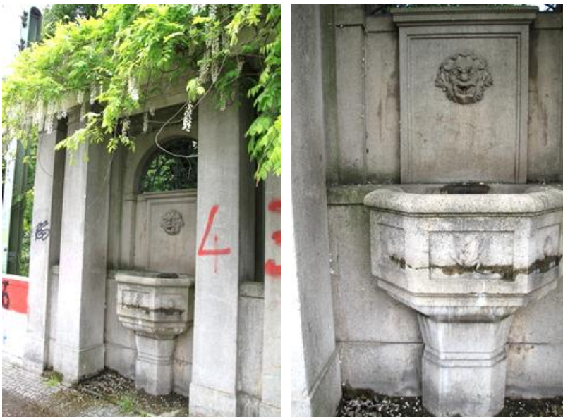
Abb. 8.34: Löwenkopfbrunnen an der Schönholzer Brücke in Berlin-Pankow
