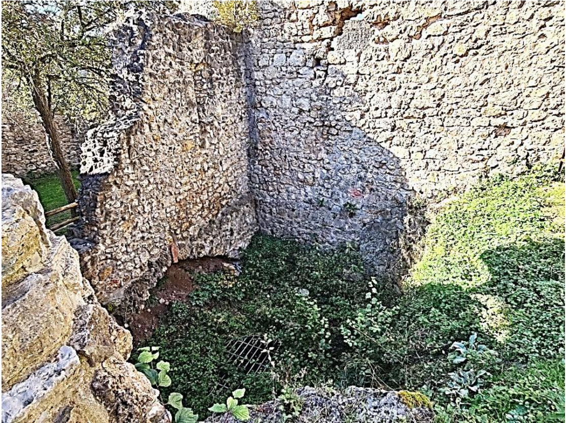
Abb. 6.26: Filterzisterne auf der Burgruine Brandenburg
