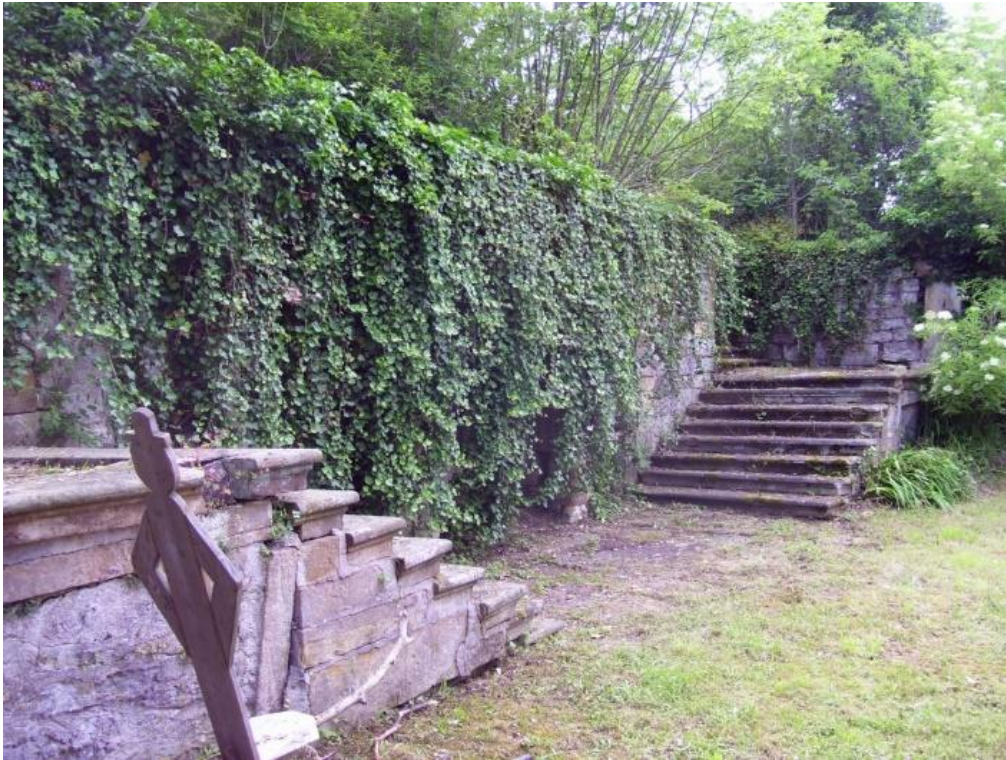
Abb. 6.45: Brunnen der ehemaligen Schlossanlage Großfahner
