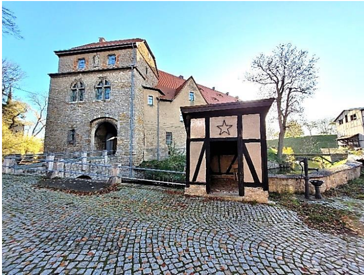
Abb. 6.15: Ordensburg Liebstedt, altes Brunnenhaus und Pumpbrunnen
