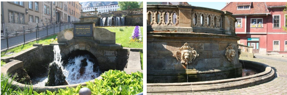
Abb. 8.10: Eine Wasserkaskade und die Pferdetränke der Gothaer Wasserkunst
