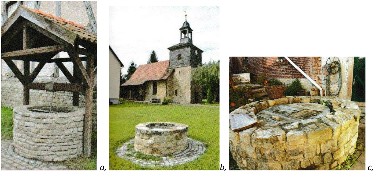
Abb. 7.55: Schachtbrunnen im Kreis Gotha a, Kleinfahner in der Kirchstraße b, Cumbach, Natursteinbrunnen auf der Festwiese vor der Kirche c, Neufrankendorf, Brunnen des ehemaligen Kammerguts
