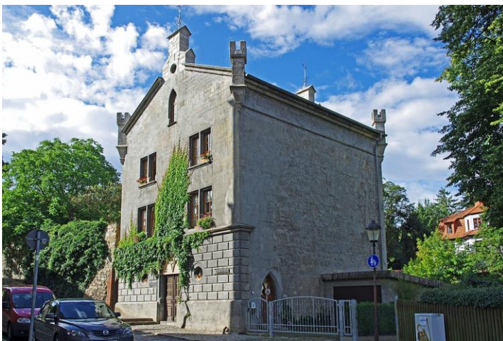
Abb. 8.23: Haus "An der Brunnenkunst 3" mit Wasserschöpftrad zur Hebung des Wassers aus der Zahmen Weiße in den Hochbehälter im Haus
