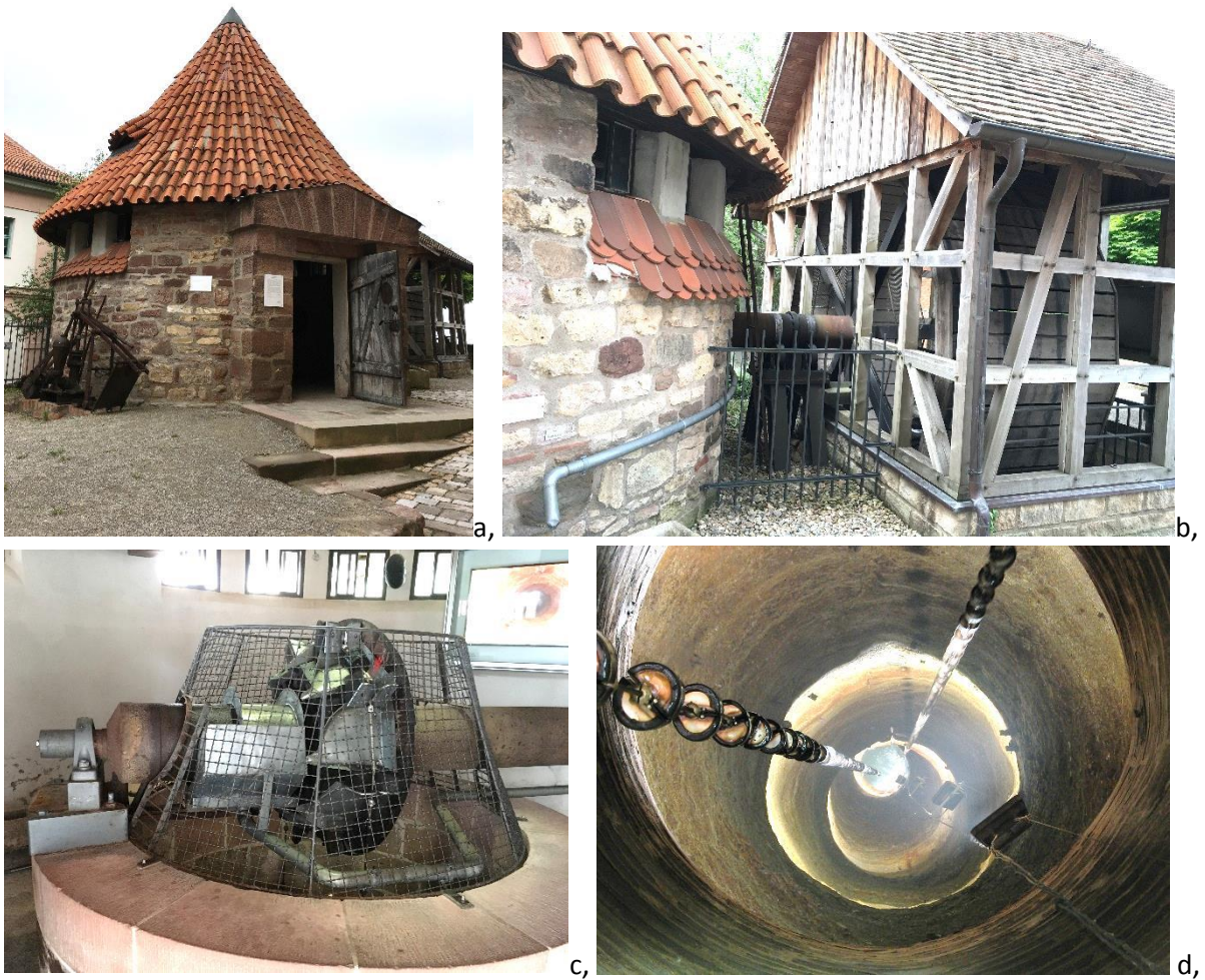
Abb. 6.18: Brunnenanlage der Leuchtenburg a, Brunnenhaus b, Tretrad c, Motorpumpe d, Brunnenschacht
