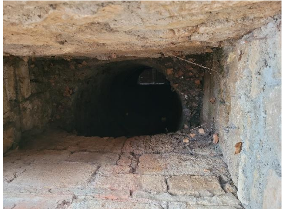
Abb. 7.57: Schachtbrunnen aus Formsteinen in Frankendorf, Am Anger 2
