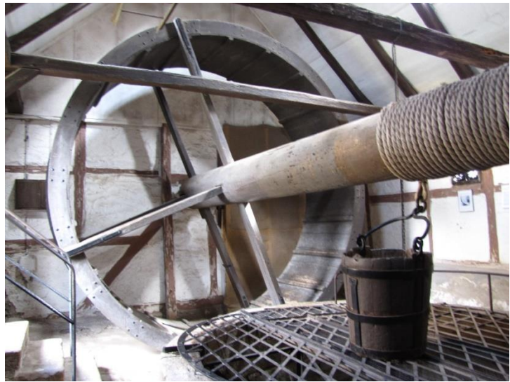
Abb. 7.82: Laufrad der Wasserhebevorrichtung des Brunnens auf der Veste Wachsenburg
