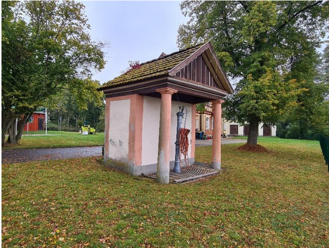
Abb. 7.62: Brunnenhaus mit Pumpe in Rieth
