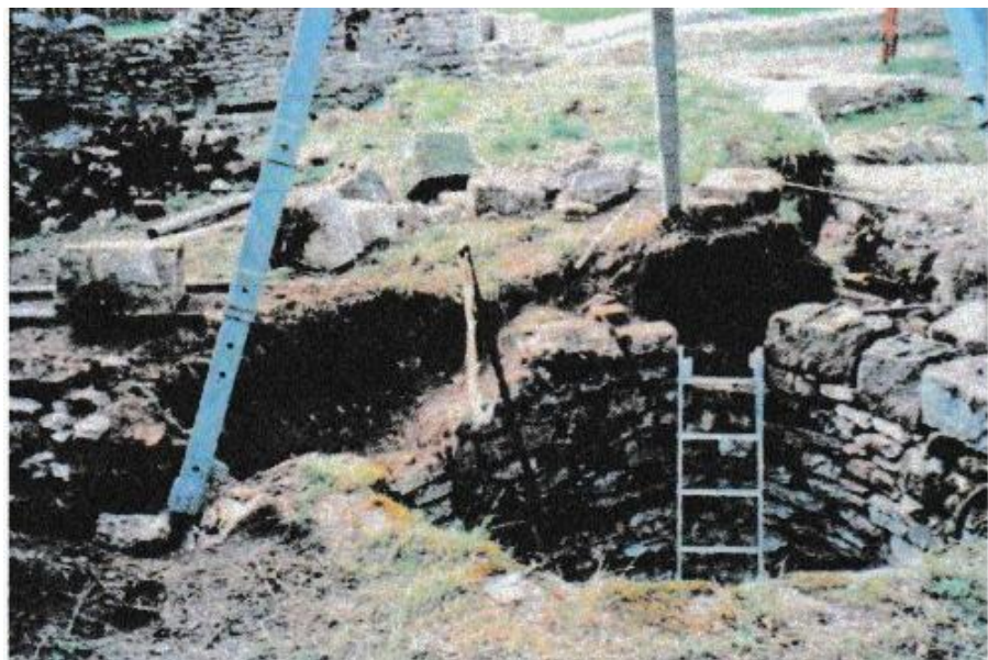
Abb. 6.27: Brunnen auf der Burg Henneberg während der Beräumung
