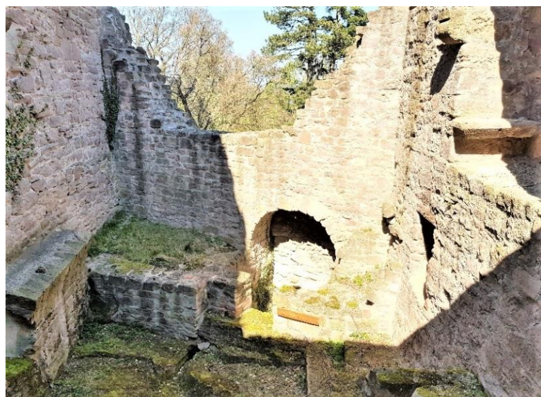
Abb. 6.10: Küchengebäude der Burg Hanstein mit Burgbrunnen
