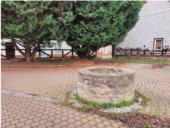
Abb. 7.49: Mit Feldsteinen gemauerte Brunnen in Heringen/Helme
