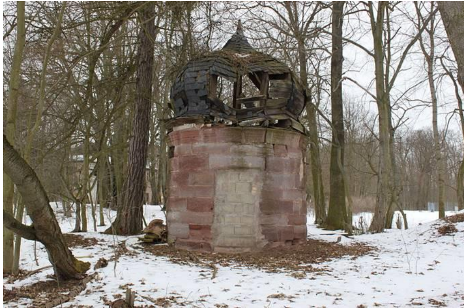
Abb. 6.51: Brunnenhaus im Park des Jagdschlusses Rathsfeld
