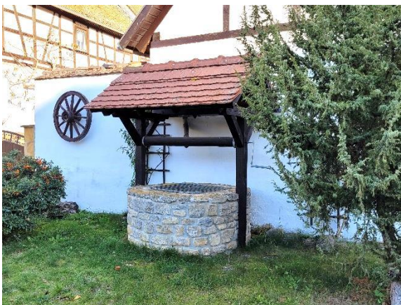
Abb. 7.36: Schachtbrunnen aus gemauerten Natursteinen in Rottdorf
