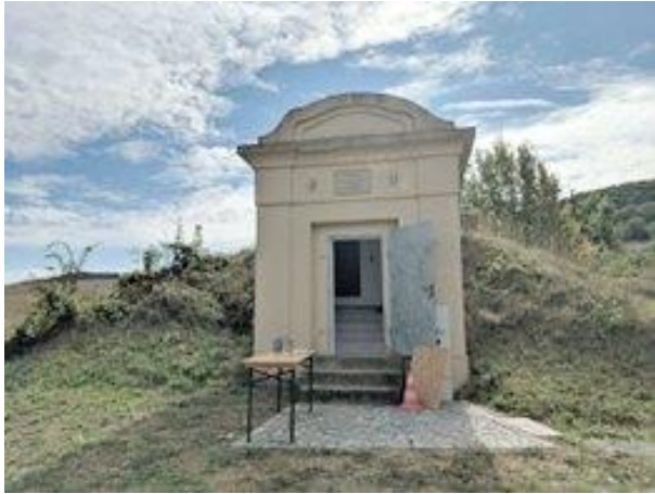
Abb. 7.64: Brunnenhaus von des Wasserwerks Golmsdorf
