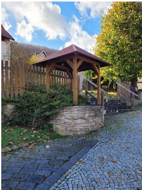
Abb. 7.56: Überdachter Schachtbrunnen in Großwenden
