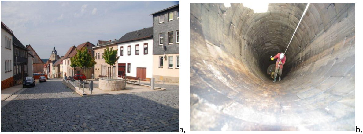
Abb. 7.23: Mittelalterlicher Brunnen in Eisfeld: a, nach der Wiederherstellung b, Blick in den Brunnenschacht während der Beräumung
