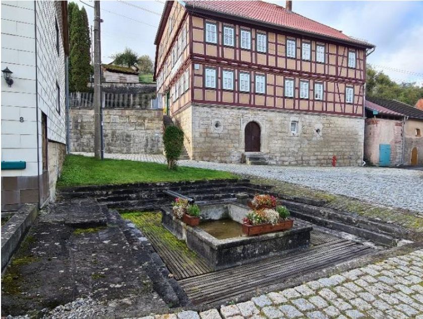
Abb. 3.55: Reste einer Quellfassung in Beilrieth
