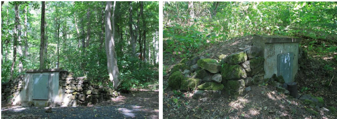
Abb. 4.51: Zwei der Quelfassungen des Grabbrunnens
