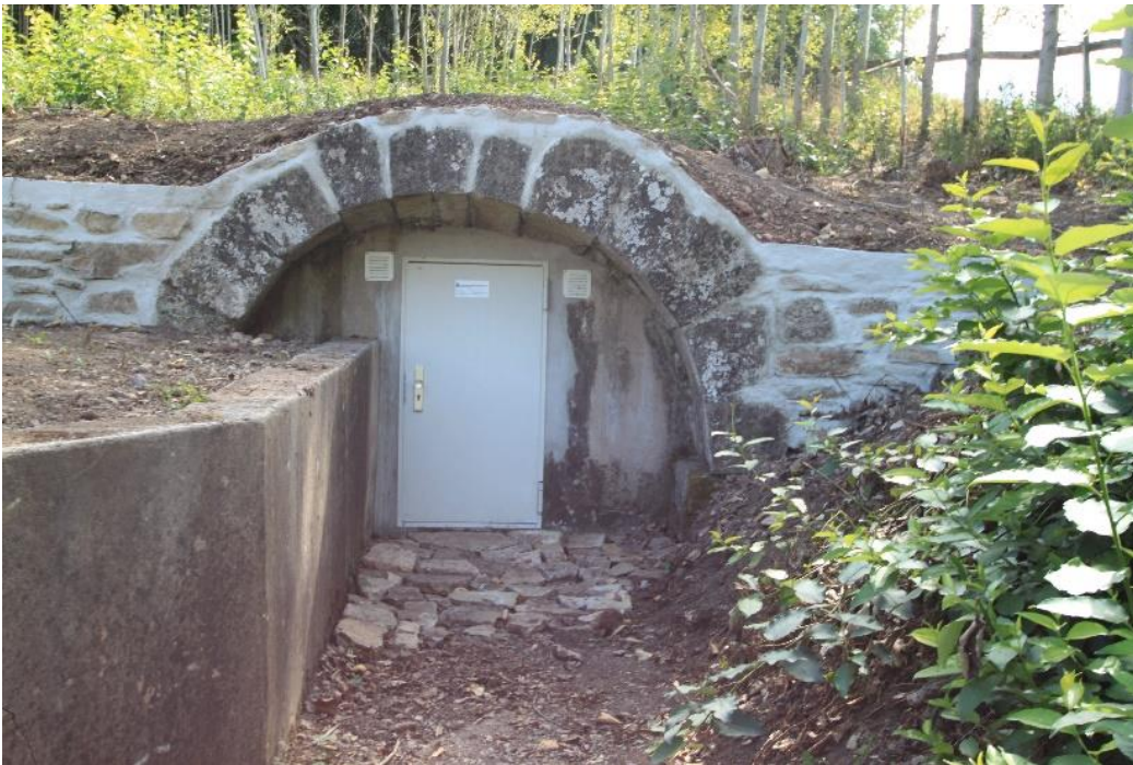
Abb. 3.38: Moderne Quellfassung der Lindenquelle im Vorwerk Beinrode
