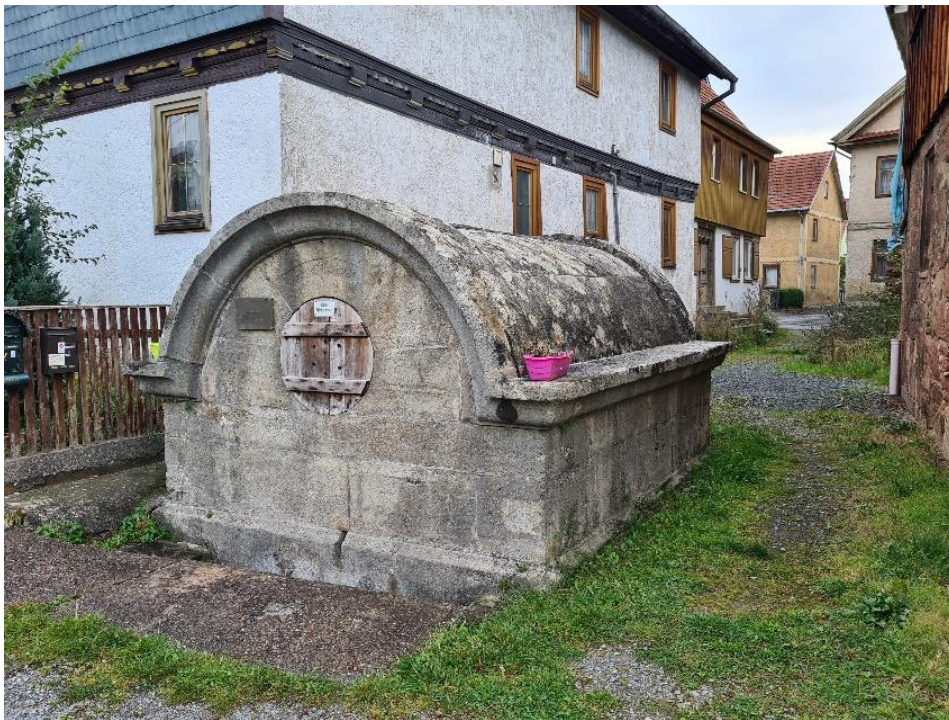
Abb. 3.67: Gewölbebrunnen in Walldorf
