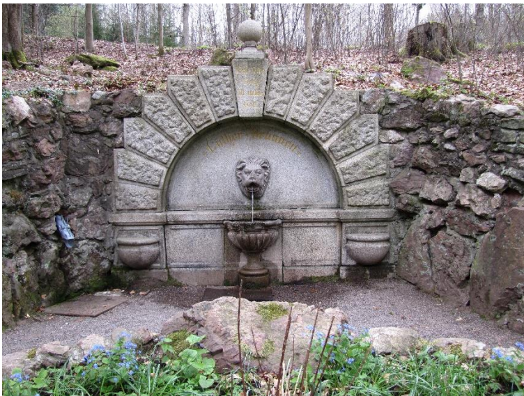
Abb. 4.75: Lutherbrunnen im Lauchgrund von Bad Tabarz
