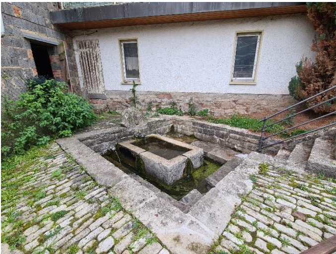
Abb. 3.56: Quellfassung in Sülzfeld
