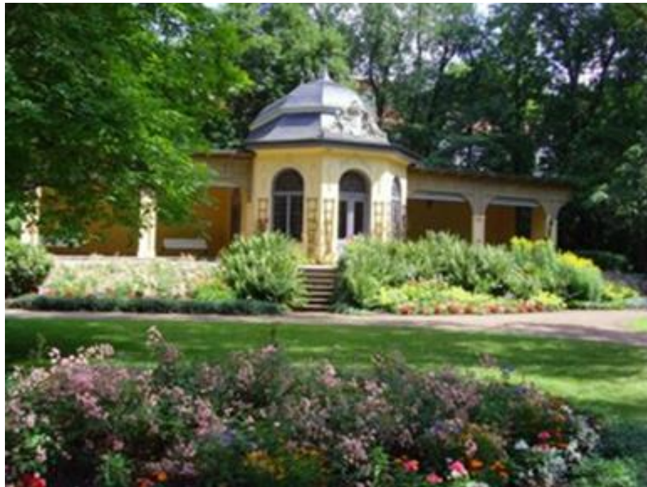
Abb. 4.28: Trinkhalle im Kurpark Bad Sulza von 1910
