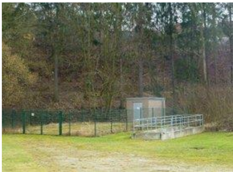
Abb. 4.5: Moderne Quelfassung des Gesundbrunnens zur Trinkwasserversorgung von Heiligenstadt
