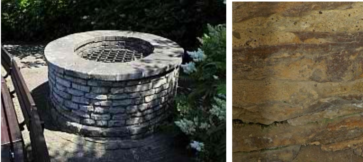
Abb. 4.26: Burgbrunnen im Park des Alten Schlosses von Sangerhausen, rechts der gemauerte Brunnenausbau
