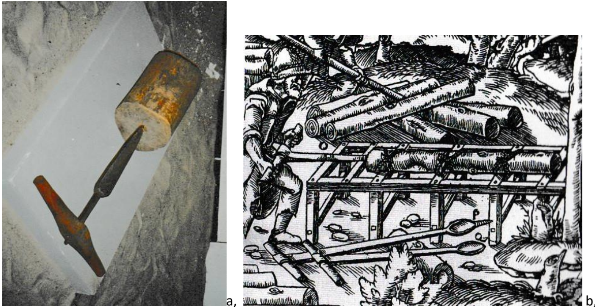
Abb. 5.11: a, Holzbohrer zur Röhrenherstellung ( Köln, Römisches Museum) b, Deichelherstellung nach Agricola (1556)
