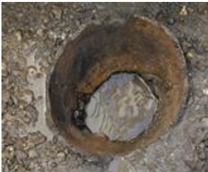
Abb. 2.4: Güsten, Topfbrunnen in situ bei abgesenktem Grundwasser
