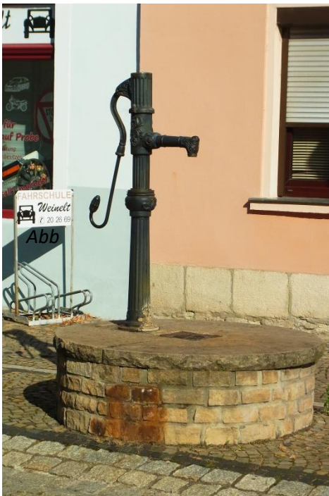
5.44: Klassischer Schachtbrunnen mit Schwengelpumpe in Naumburg
