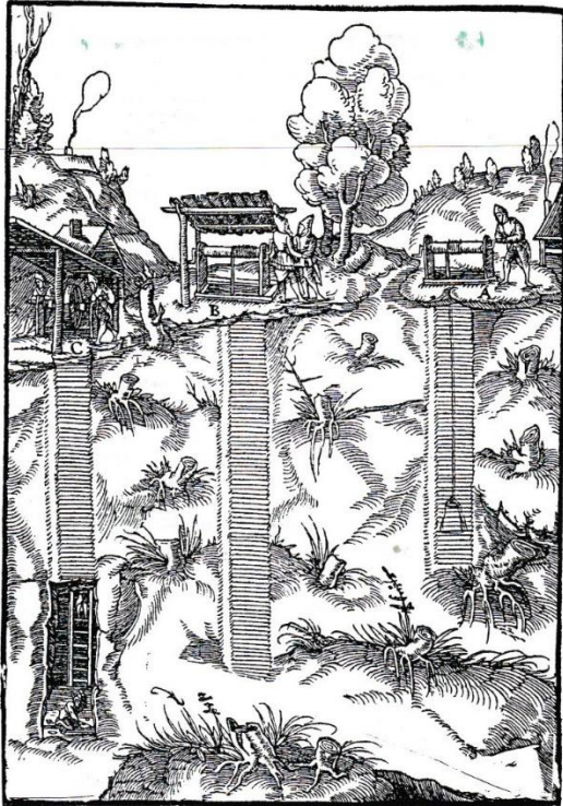
Abb. 4.1: Historische Darstellung a, des Schachtbaus b, des Schachtverbaus (Agricola 1556)
