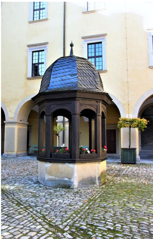
Abb. 4.23: Tiefbrunnen auf der Moritzburg in Zeitz
