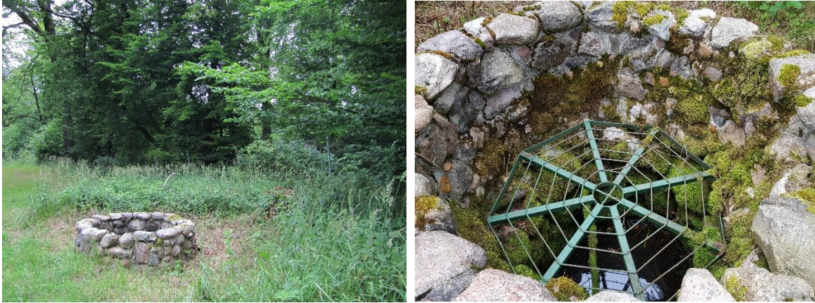
Abb. 5.50: Mittelalterlicher Schachtbrunnen in der Wüstung Schleesen
