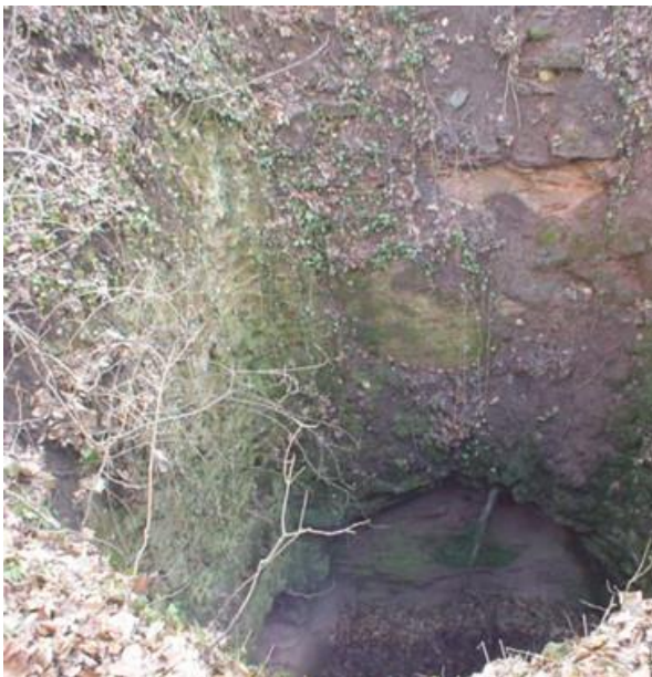
Abb. 4.25: Zisterne auf der Burgruine Grillenburg im unteren Harz
