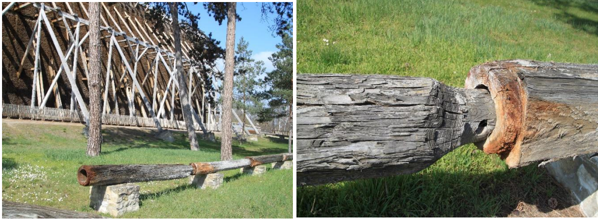
Abb. 5.13: Holzröhrenleitung (Bad Salzelmen), rechts Verbindung der Holzröhren mittels Muffe
