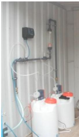
Abb. 4-14: Dosieranlage für zwei Medien im Container
