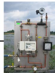
CO<sub>2</sub>-Dosierung über Steuertafel in den Förderluftstrom
