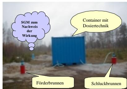
Abb. 3 Versuchsanlage im südlichen Grundwasseranstrom des Senftenberger Sees
