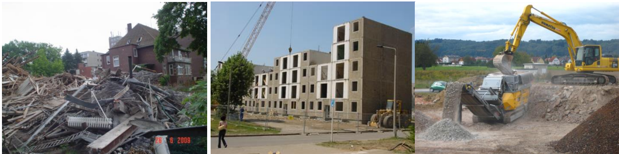
Abbildung 1: Abbruch einer Villa (Bremen), Teilrückbau Plattenbau (Schwedt) und Bauschutttaufbereitung
