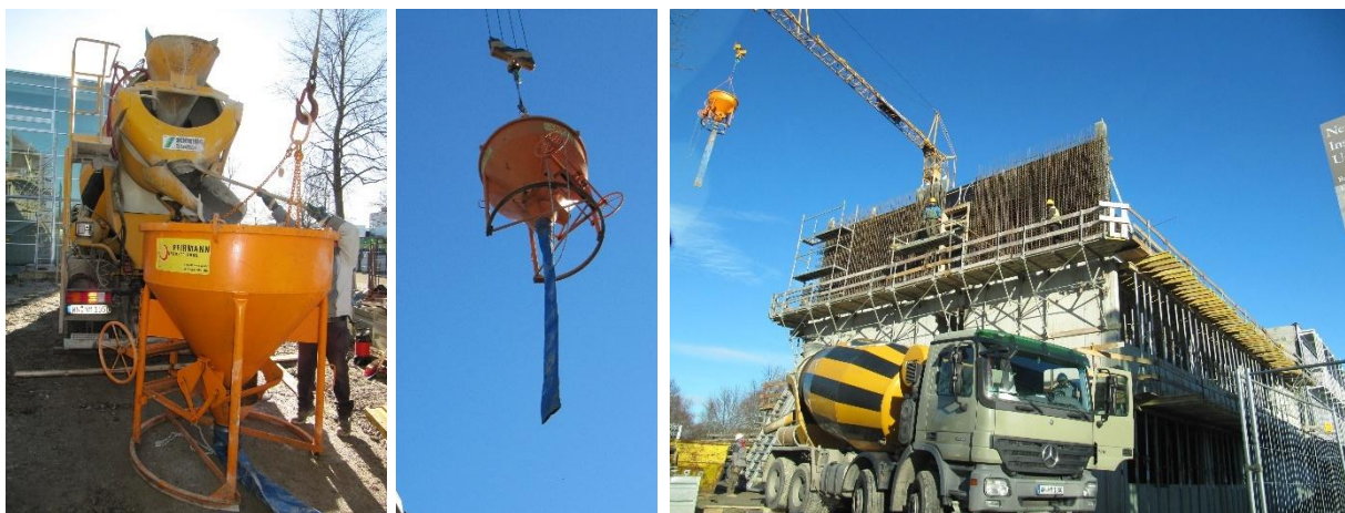
Abbildung 14: Betonierarbeiten bei der Errichtung des Tragwerks
