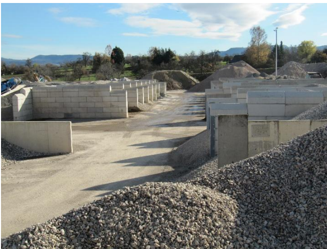
Abbildung 5: Schüttgutlager Fa. Heinrich Feeß GmbH & Co. KG [Foto: Mettke, 10.11.2015]
