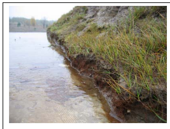
Abb. 302 : Überlaufrinne im Kronenbereich nach Überströmung der Überlaufstrecke Var. 3.1 mit 40 cm Überstau
