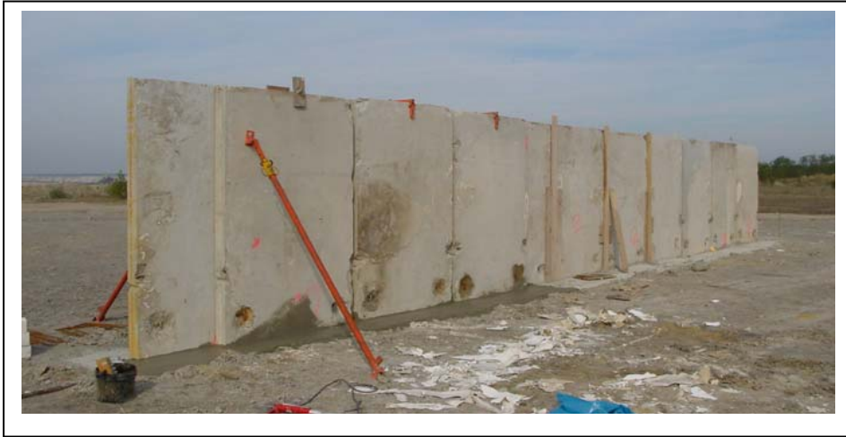
Abb. 116 : Herstellung der Innendichtung
