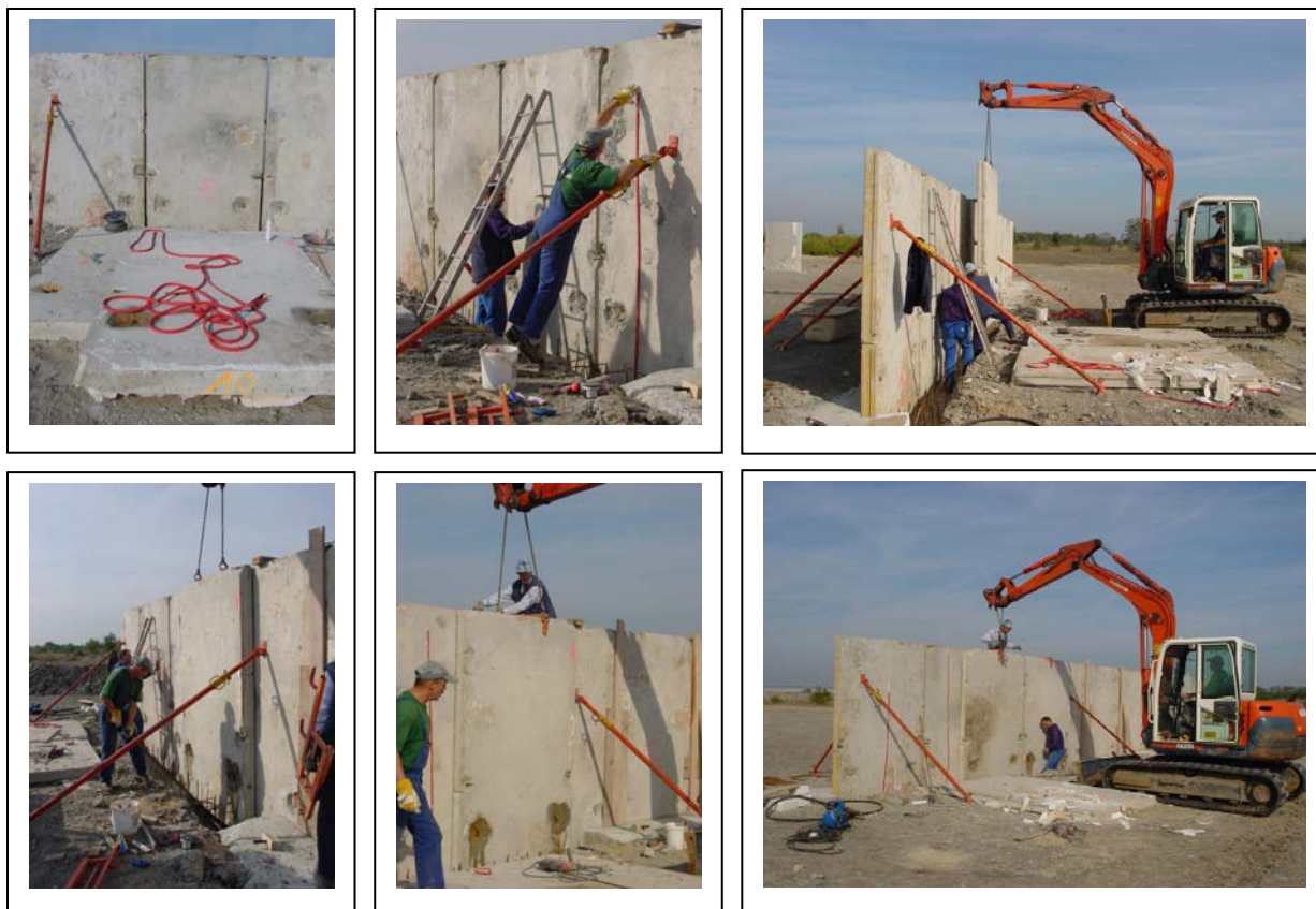
Abb. 130 : Herstellung der doppelwandigen Innendichtung mit Dichtungsband
