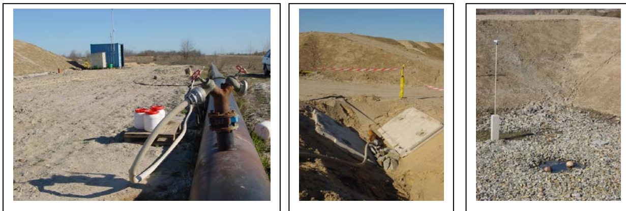
Abb. 196 : Wasserentnahme, Schlauch- und Rohrleitung zum Befüllen des Speicherbeckens
