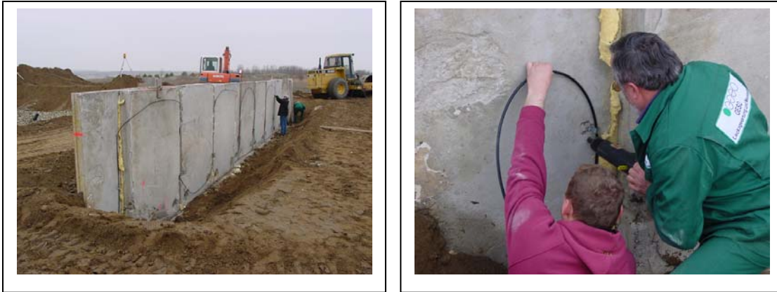
Abb. 186 : Verlegtes GESO-Temperatursensorkabel zur Leckageüberwachung der Innendichtung
