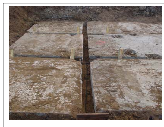
Abb. 184 : Verlegtes GESO-Temperatursensorkabel zur Leckageüberwachung der Oberflächendichtung
