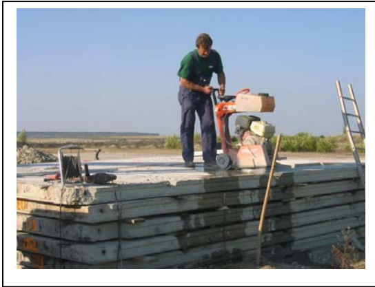
Abb. 124 : Halbieren der RC-Betonbauteile
