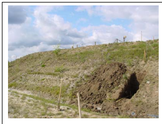
Abb. 247 : Suchschachtungen im homogenen Bereich und im Untersuchungsabschnitt mit Oberflächendichtung
