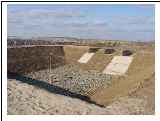
Abb. 162 : Oberflächendichtung / Überlauf-/Überströmstrecken (li.) und Homogener Deich / Oberflächendichtung (re.), wasserseitig
