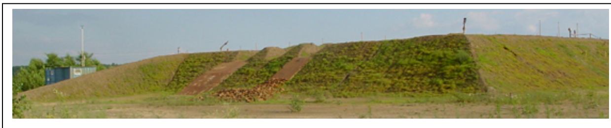
Abb. 161 : Überlauf-/Überströmstrecken (Var. 3.1 links, Var. 3.2 rechts und Var. 3.3 mittig), landseitig
