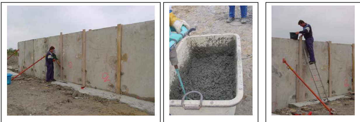
Abb. 128 : Herstellen der Fugendichtung aus Betonmörtel im mittleren Untersuchungsabschnitt der Innendichtung
