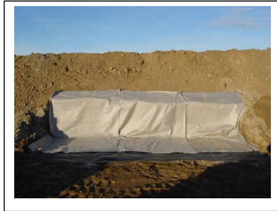
Abb. 150 : Verlegen des Geotextils für die Drainageschicht (Filterprisma)
