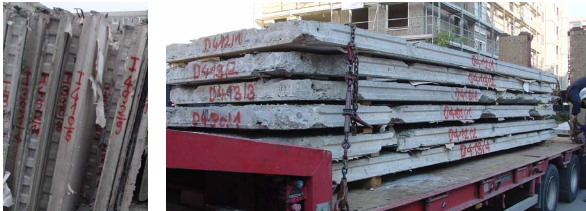
Abb. 58 : Ausgebaute Innenwandbauteile und Deckenplatten eines WBS 70 – Wohnblocks
