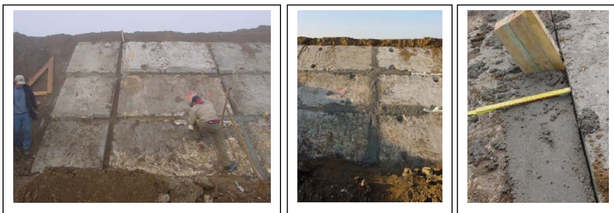
Abb. 140 : Fugenabdichtung mit Betonmörtel (Oberflächendichtung)
