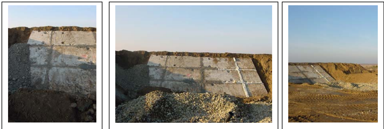
Abb. 142 : Fertiggestellte Fugenabdichtung der Oberflächendichtung
