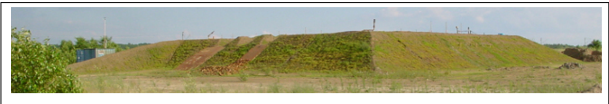
Abb. 157 : Fertiggestellter Versuchsdeichkörper, landseitig
