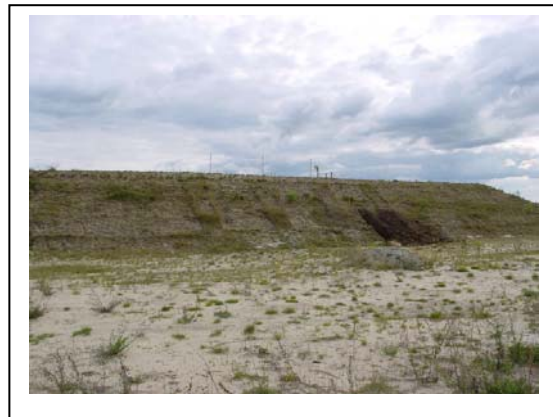
Abb. 247 : Suchschachtungen im homogenen Bereich und im Untersuchungsabschnitt mit Oberflächendichtung
