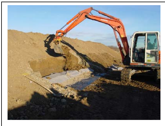
Abb. 152 : Abdecken des Filterfußes mit Erdstoff
