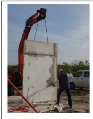
Abb. 125 : Anschlag der RC-Betonbauteile
