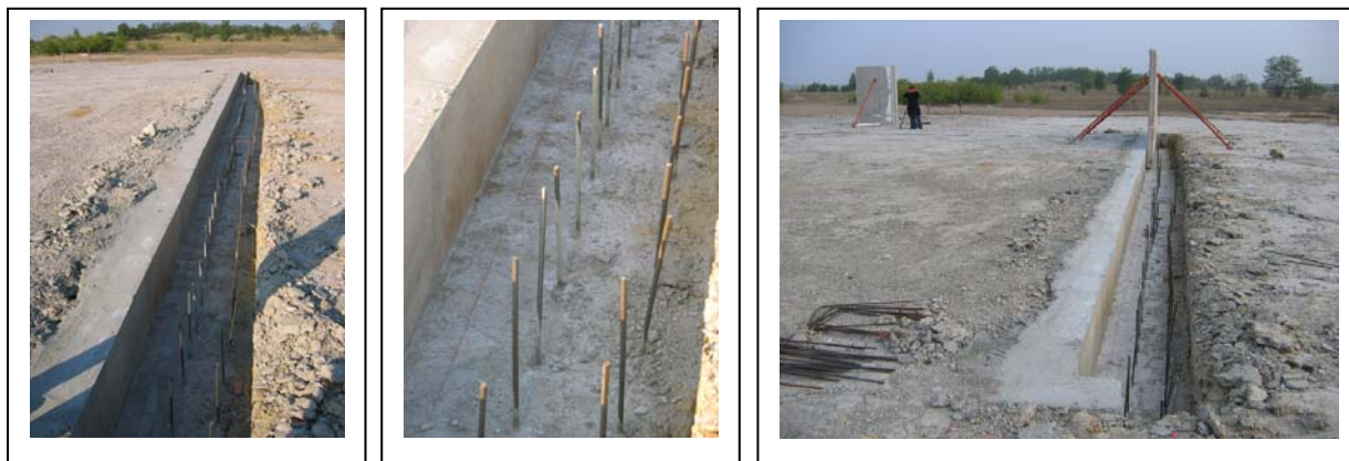
Abb. 122 : Streifenfundament der Innendichtung – Var. 2
