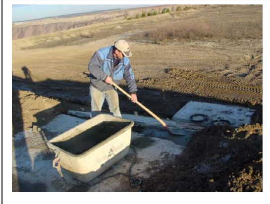
Abb. 146 : Schließen der Fugen der Überlaufstrecken mit Betonmörtel
