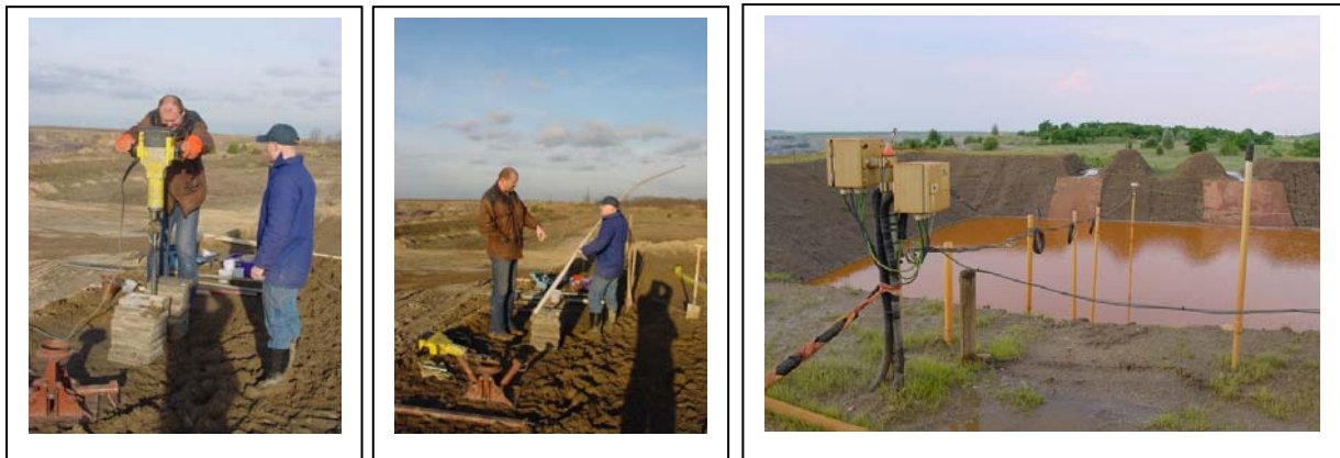
Abb. 180 : Einbau der Pegel und Pegelmesspunkte mit Anschlusskasten (re.)
