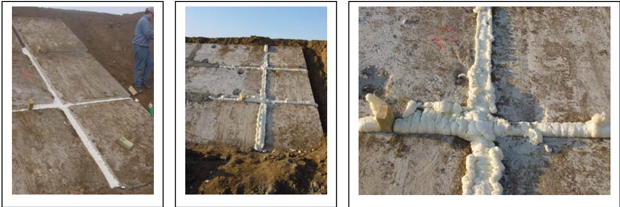
Abb. 141 : Fugenabdichtung mit Brunnenschaum (Oberflächendichtung)
