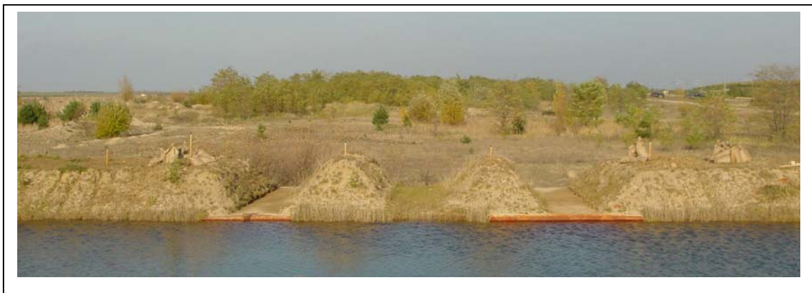
Abb. 292 : Überlaufstrecken wasserseitig vor den Überströmversuchen
