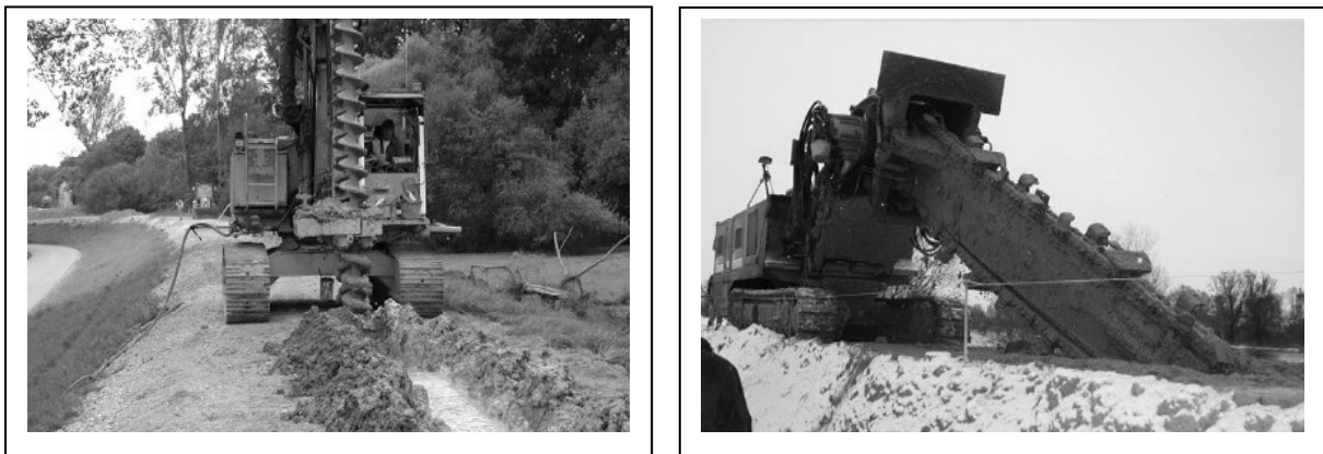
Abb. 27 : MIP-Gerät (li.); Grabenfräse (FMI-Verfahren) 61 (re.)
