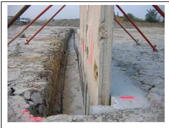
Abb. 126 : Gestellte und gesicherte RC-Bauteile der Innendichtung
