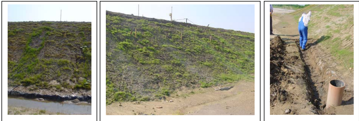
Abb. 192 : Versandete Abflussrinne zur Durchflussmessung
