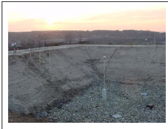
Abb. 162 : Oberflächendichtung / Überlauf-/Überströmstrecken (li.) und Homogener Deich / Oberflächendichtung (re.), wasserseitig
