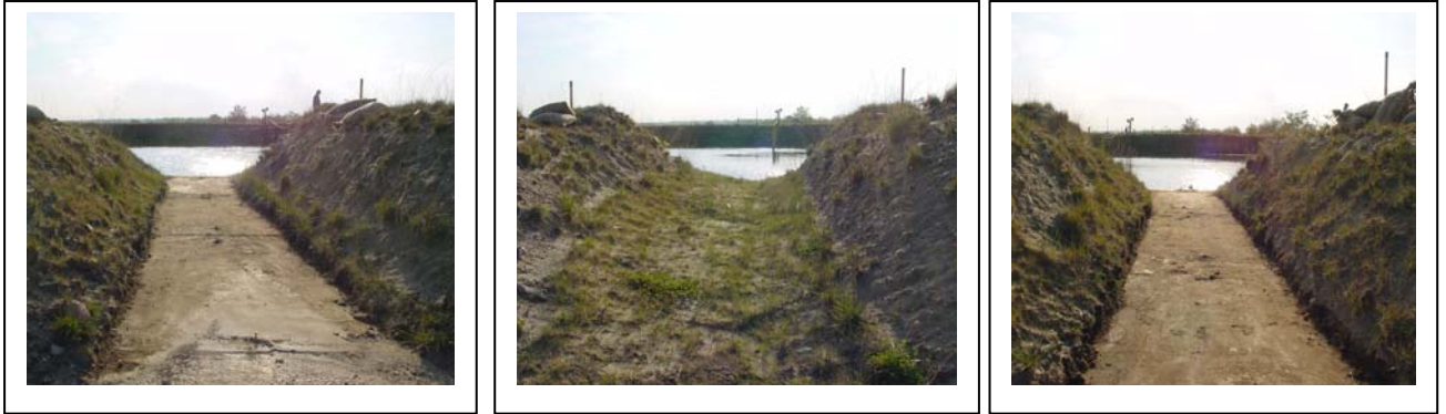
Abb. 294 : Kronenbereiche der Überlaufstrecken der Var. 3.1, Var. 3.3 und Var. 3.2 (v.l.n.r.)
