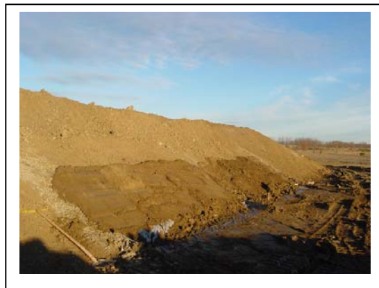
Abb. 151 : Einbau der Filterkiesschicht und Umschlagen des Geotextils
