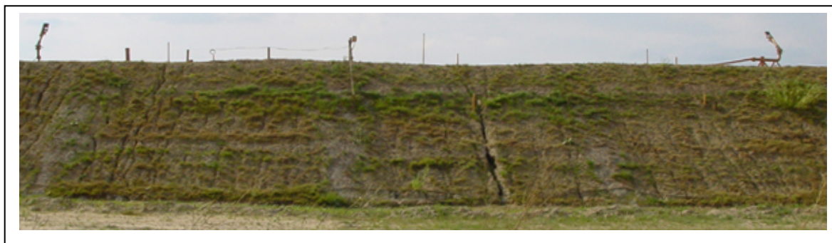
Abb. 244 : Keine Vernässung des Untersuchungsabschnitts mit Innendichtung nach 8 Tagen Volleinstau
