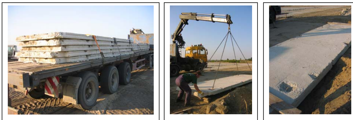
Abb. 123 : Anlieferung der RC-Betonbauteile
