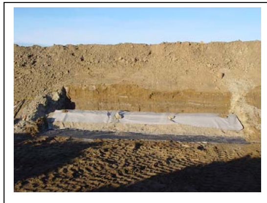
Abb. 151 : Einbau der Filterkiesschicht und Umschlagen des Geotextils
