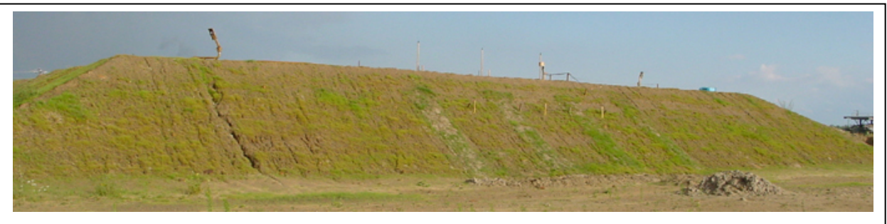
Abb. 159 : Oberflächendichtung (Var. 1), landseitig
