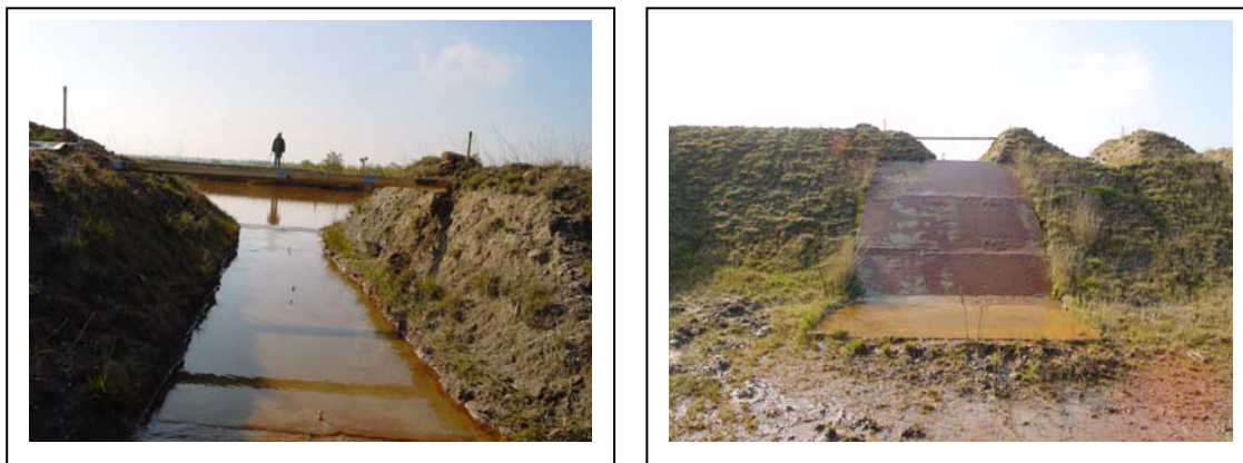
Abb. 299 : Überlaufrinne im Kronenbereich und landseitige Böschung nach Überströmung der Überlaufstrecke Var. 3.1 mit 20 cm Überstau
