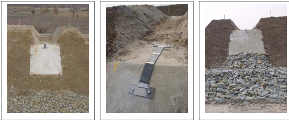
Abb. 148 : Sicherung der RC-Bauteile auf den Böschungen der Überlaufstrecke Var. 3.2
