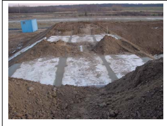
Abb. 146 : Schließen der Fugen der Überlaufstrecken mit Betonmörtel
