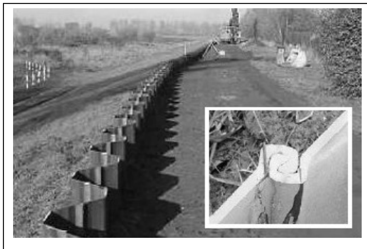
Abb. 26 : Einbau einer Spundwand (kleines Bild: „Schloss“) 59
