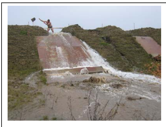
Abb. 301 : Überströmung der Überlaufstrecke Var. 3.1 mit 40 cm Überstau
