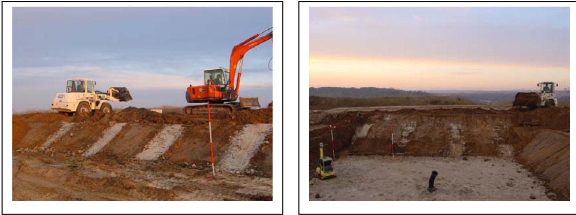
Abb. 137 : Weiterer Einbau des Deichgrundkörpers über den zum Teil fertiggestellten Tonschotts
