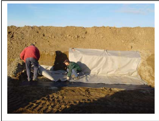
Abb. 150 : Verlegen des Geotextils für die Drainageschicht (Filterprisma)
