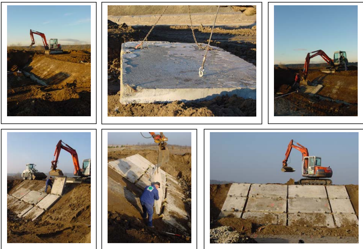
Abb. 138 : Verlegen der RC-Bauteile der Oberflächendichtung
