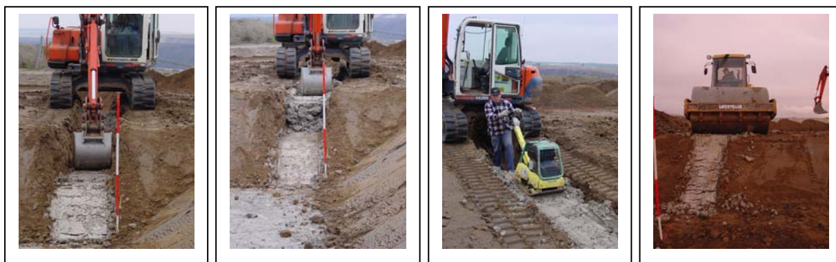
Abb. 136 : Arbeitsschritte zum lagenweisen Einbauen der Tonschotts unter der Oberflächendichtung
