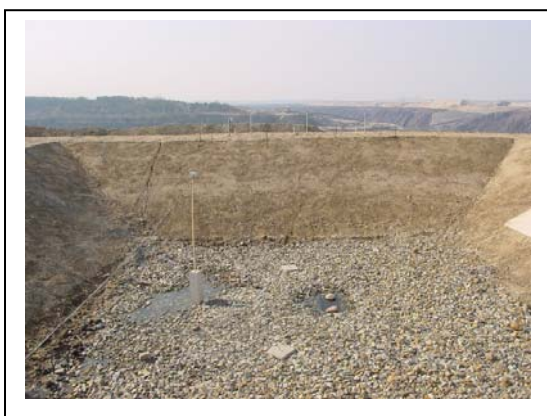
Abb. 163 : Innendichtung (li.), wasserseitig und gefülltes Speicherbecken (re.),
