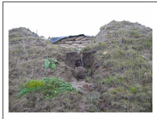
Abb. 307 : Landseitige Böschung nach Überströmung der Überlaufstrecke Var. 3.3 mit 20 cm Überstau
