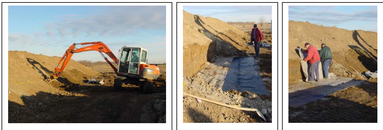
Abb. 149 : Freilegen des landseitigen Böschungsfußes und Einbringen der Folienbahn und des Geotextils für die Drainageschicht (Filterprisma)
