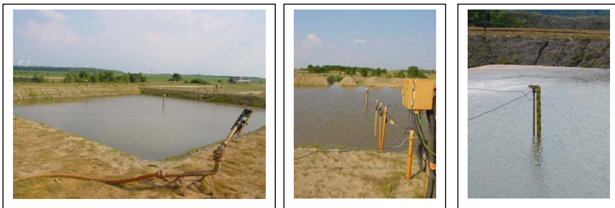
Abb. 198 : Volleinstau auf 2,3 m Wasserstand (1. Messkampagne) vom 07.08.2007
