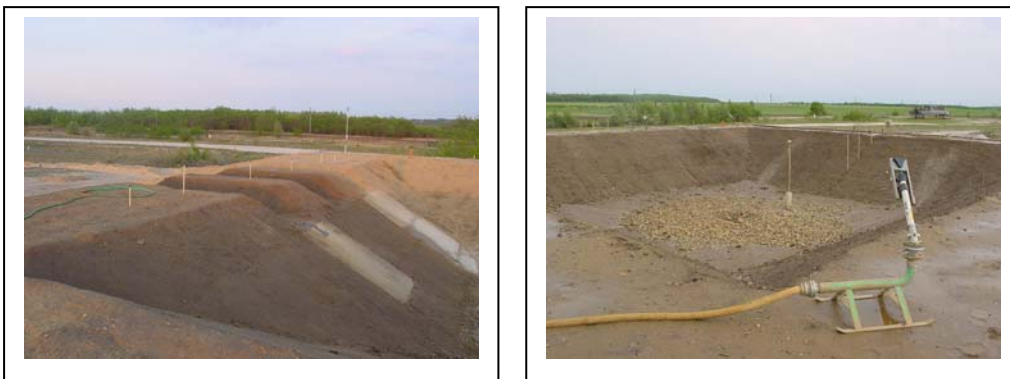
Abb. 154 : Manuelle Bewässerung mit dem Gartenschlauch (li.) Bewässerungsanlage (re.)
