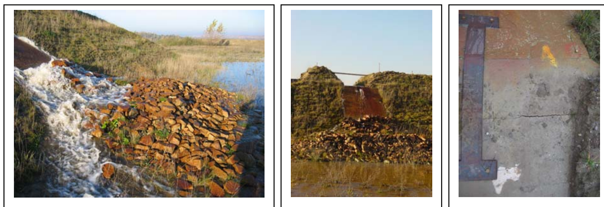
Abb. 305 : Landseitige Böschung und RC-Bauteilfugen im Kronenbereich nach Überströmung der Überlaufstrecke Var. 3.2 mit 20 cm Überstau
