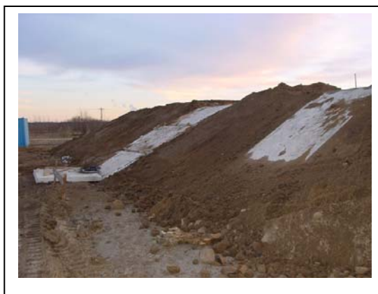
Abb. 145 : Verlegen der RC-Bauteile für die Überlaufstrecken Var. 3.1 und 3.2
