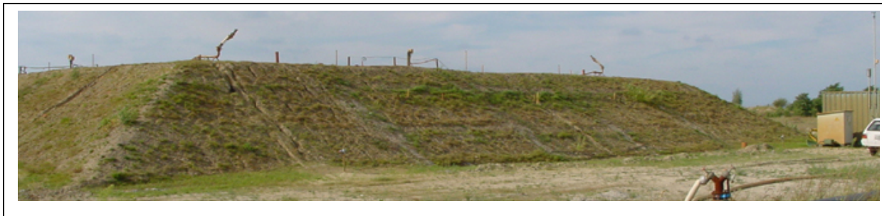
Abb. 160 : Innendichtung (Var. 2), landseitig
