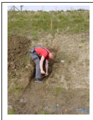
Abb. 248 : Suchschachtungen im Untersuchungsabschnitt mit Innendichtung
