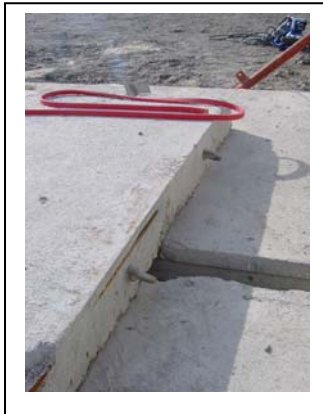
Abb. 125 : Anschlag der RC-Betonbauteile
