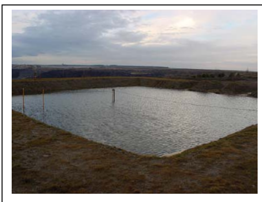
Abb. 163 : Innendichtung (li.), wasserseitig und gefülltes Speicherbecken (re.),
