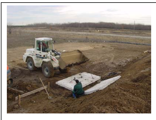
Abb. 145 : Verlegen der RC-Bauteile für die Überlaufstrecken Var. 3.1 und 3.2
