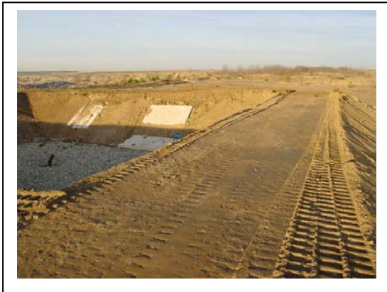
Abb. 147 : Fertigstellung der Überlaufstrecken
