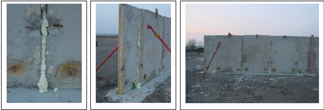
Abb. 132 : Herstellen der Fugendichtung mit doppeltgestellten RC-Bauteilen und Brunnenschaum (Innendichtung)
