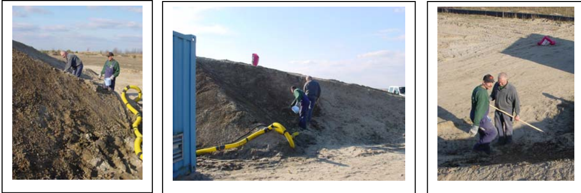
Abb. 153 : Erstaussaat des Rasens zur Deichbegrünung
