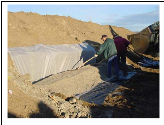
Abb. 151 : Einbau der Filterkiesschicht und Umschlagen des Geotextils
