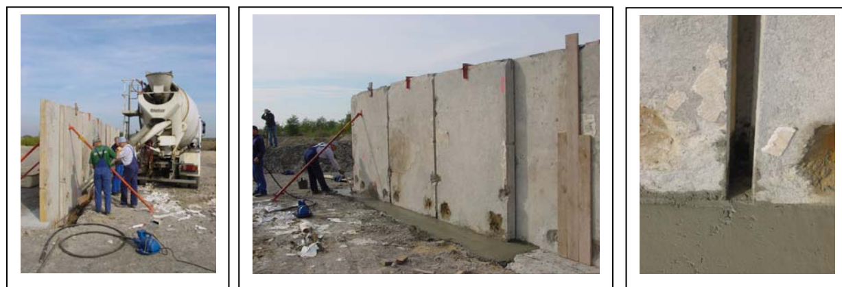
Abb. 131 : Fertigstellen des Streifenfundamentes (Innendichtung)
