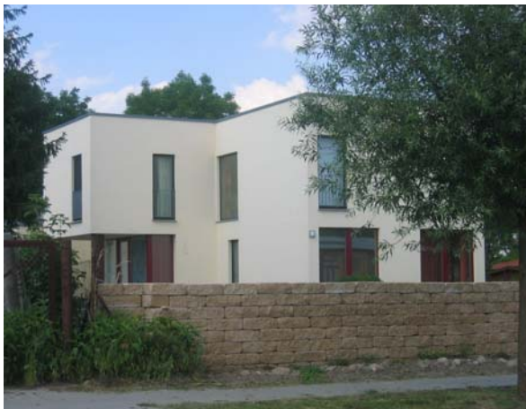
Abb. 158 : Rohbau-Einfamilienhaus in Mehrow, bei Berlin
