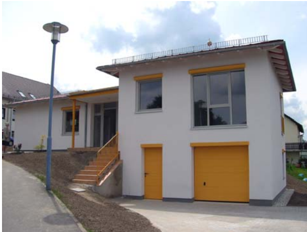
Abb. 159 : Einfamilienhaus in Plauen
