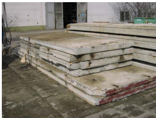
Abb. 53 : Zwischengelagerte Deckenplatten im Außenbereich
