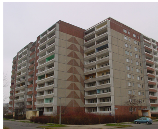
Abb. 29 : Gebäude der Typenserie WBS 70/11 (Standort Berlin-Marzahn)
