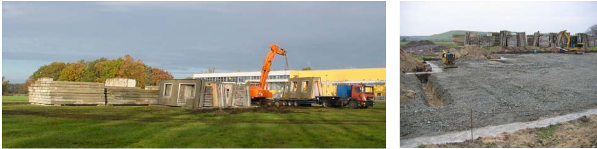
Abb. 163 : Vereinshaus Gröditz zwischengelagerte Platten (li.), Betonieren der Frostschränke (re.)
