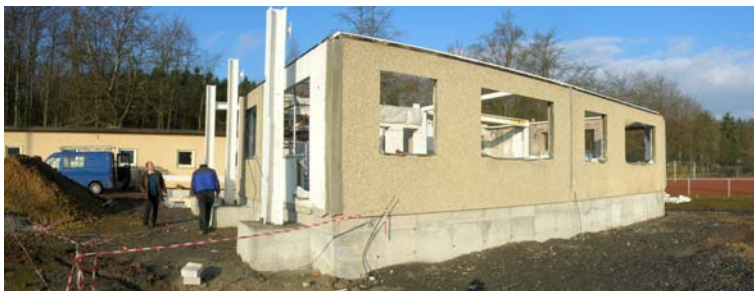
Abb. 166 : Remontage der Wandelemente eines Segmentes - Vereinshaus Plauen
