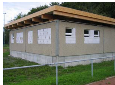
Abb. 167 : Zwischenbauzustände der Remontage eines Segmentes - Vereinshaus Plauen
