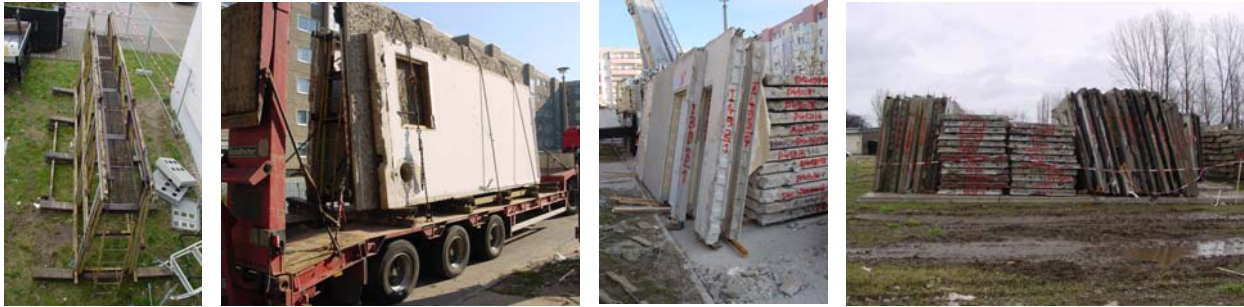
Abb. 96 : A-Bock, Sicherung der Transportladung, Sicherung der Türschäfte und Zwischenlagerung von Außenwandelementen (v.l.n.r.)
