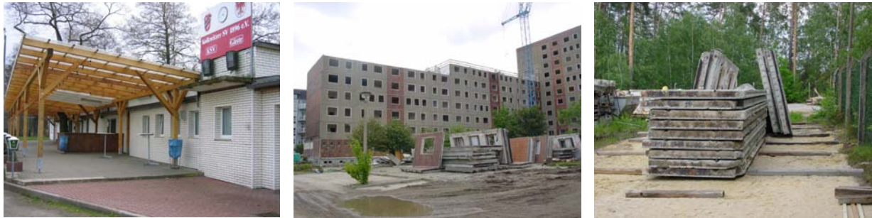
Abb. 173 : Altes Vereinsgebäude (li.), Spendergebäude (mi.), Zwischenlager (re.) - Vereinshaus Kolkwitz
