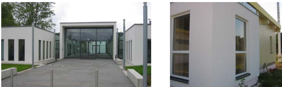
Abb. 170 : Fertiggestellte Segmente - Vereinshaus Plauen
