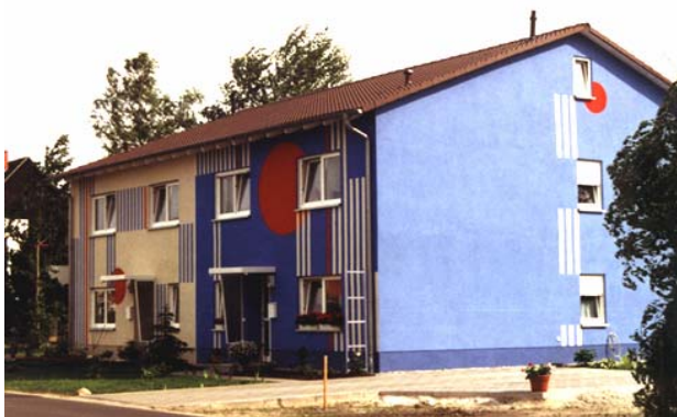
Abb. 156 : Zweifamilienhaus in Bröthen
