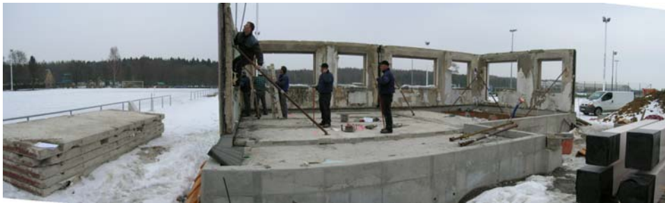
Abb. 166 : Remontage der Wandelemente eines Segmentes - Vereinshaus Plauen
