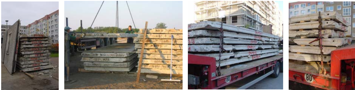
Abb. 94 : Zwischenlagerung und Transport von Deckenplatten
